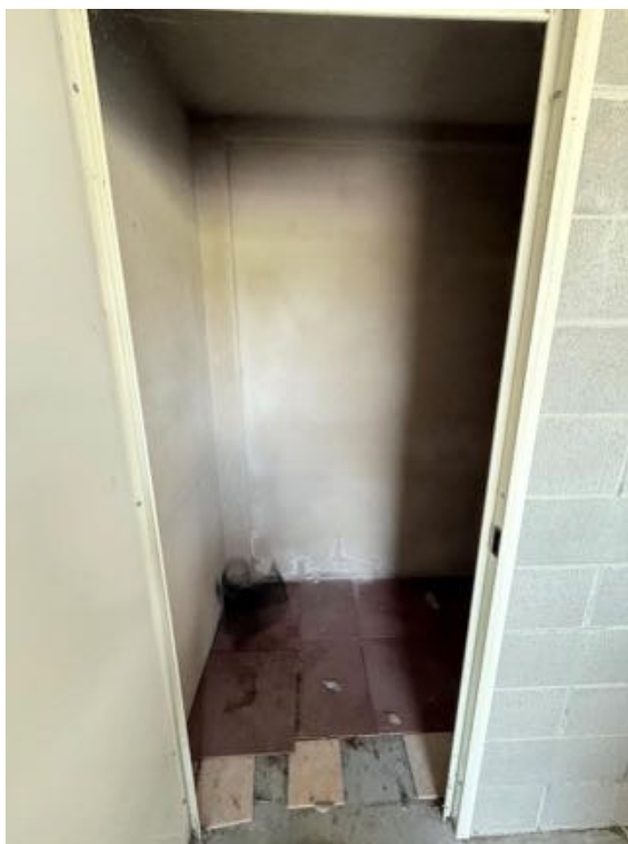
Piano Terra - Cantina (Sub. 4) - (foto 2)
