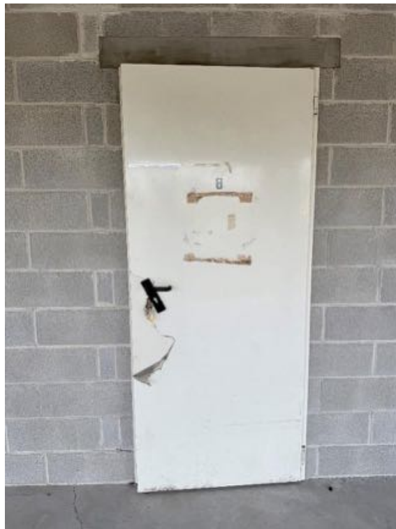
Piano Terra - Cantina (Sub. 8) - (foto 1)
