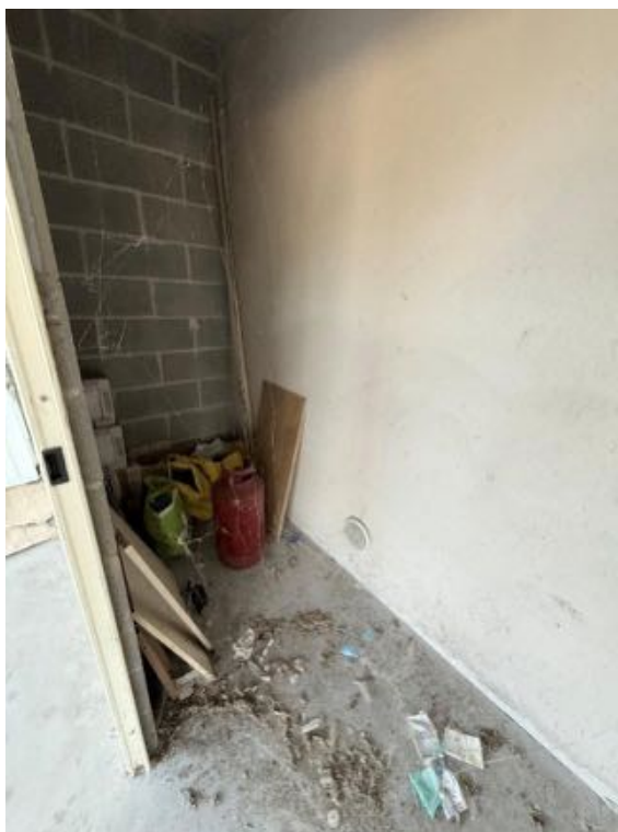
Piano Terra - Cantina (Sub. 15) - (foto 2)
