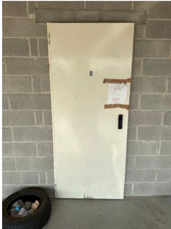
Piano Terra - Cantina (Sub. 9) - (foto 1)
