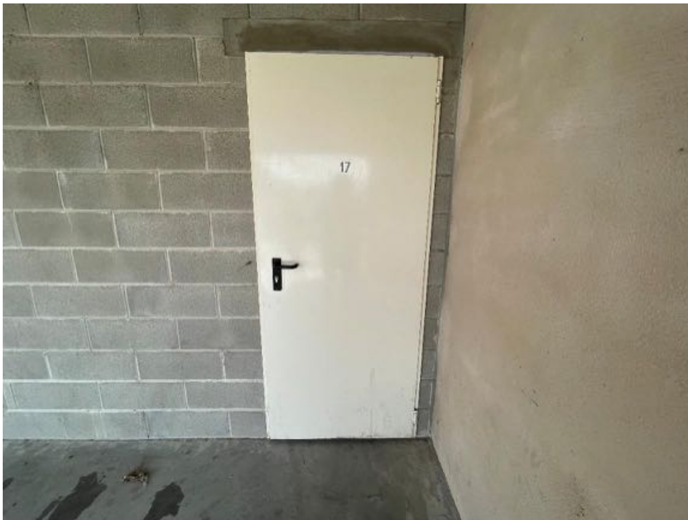
Piano Terra - Cantina (Sub. 17) - (foto 1)
