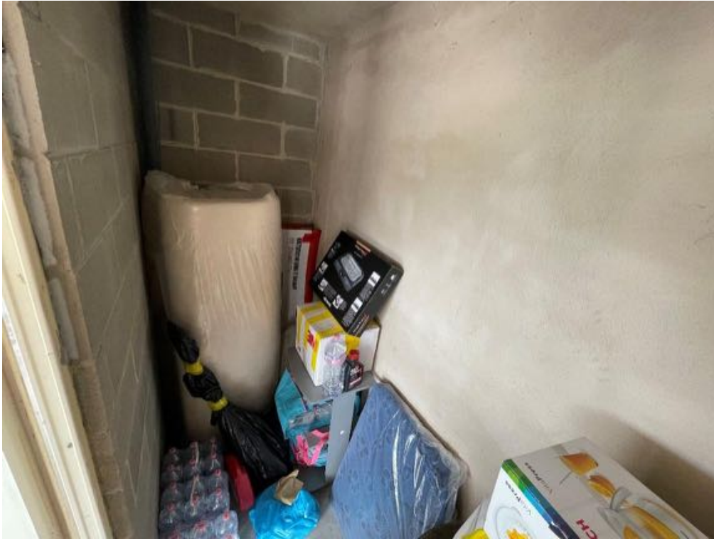
Piano Terra - Cantina (Sub. 13) - (foto 2)
