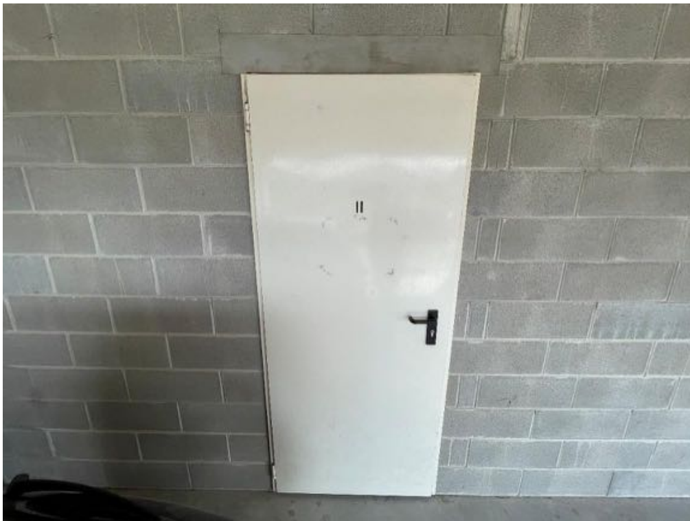
Piano Terra - Cantina (Sub. 11) - (foto 1)
