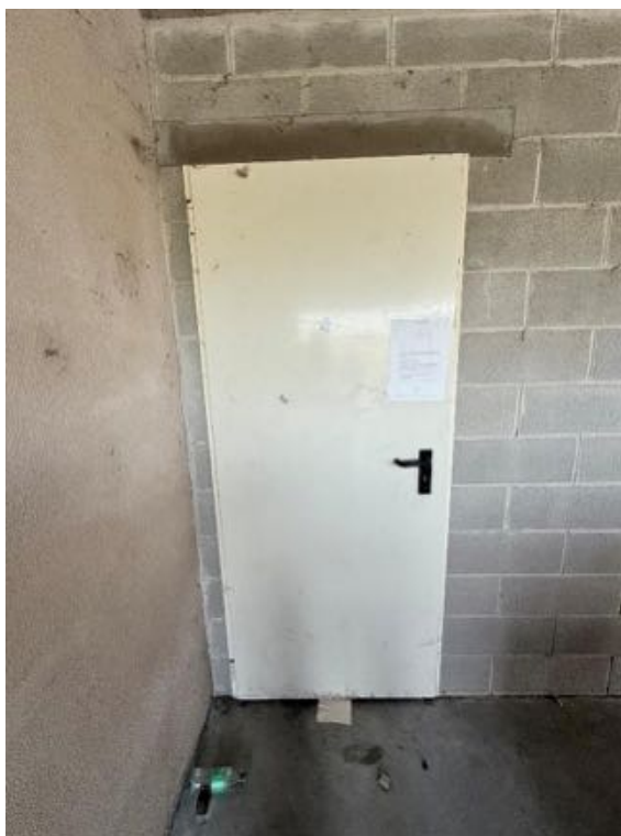
Piano Terra - Cantina (Sub. 4) - (foto 1)
