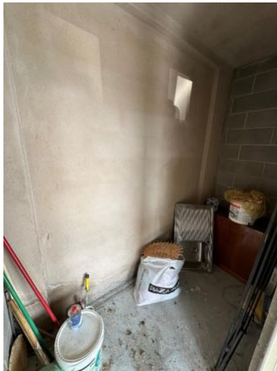
Piano Terra - Cantina (Sub. 9) - (foto 2)
