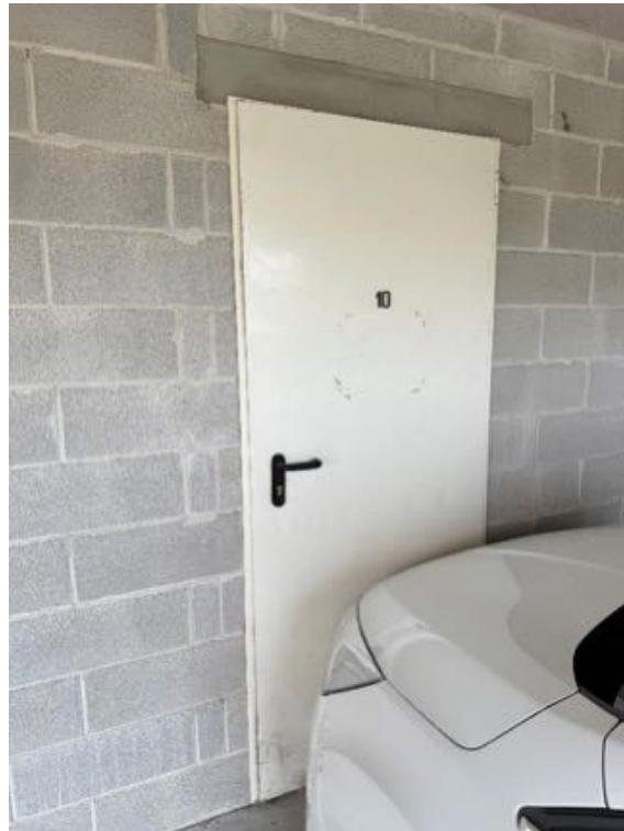
Piano Terra - Cantina (Sub. 10) - (foto 1)
