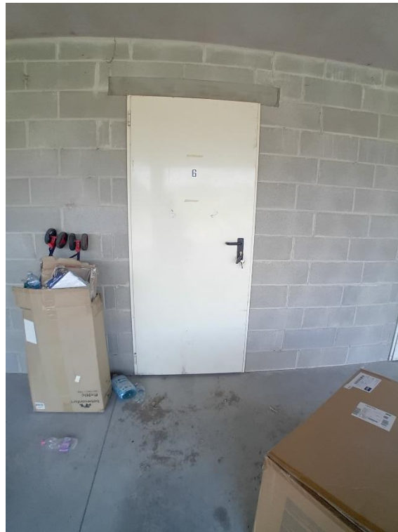
Piano Terra - Cantina (Sub. 6) - (foto 1)
