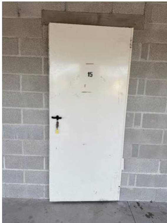
Piano Terra - Cantina (Sub. 15) - (foto 1)
