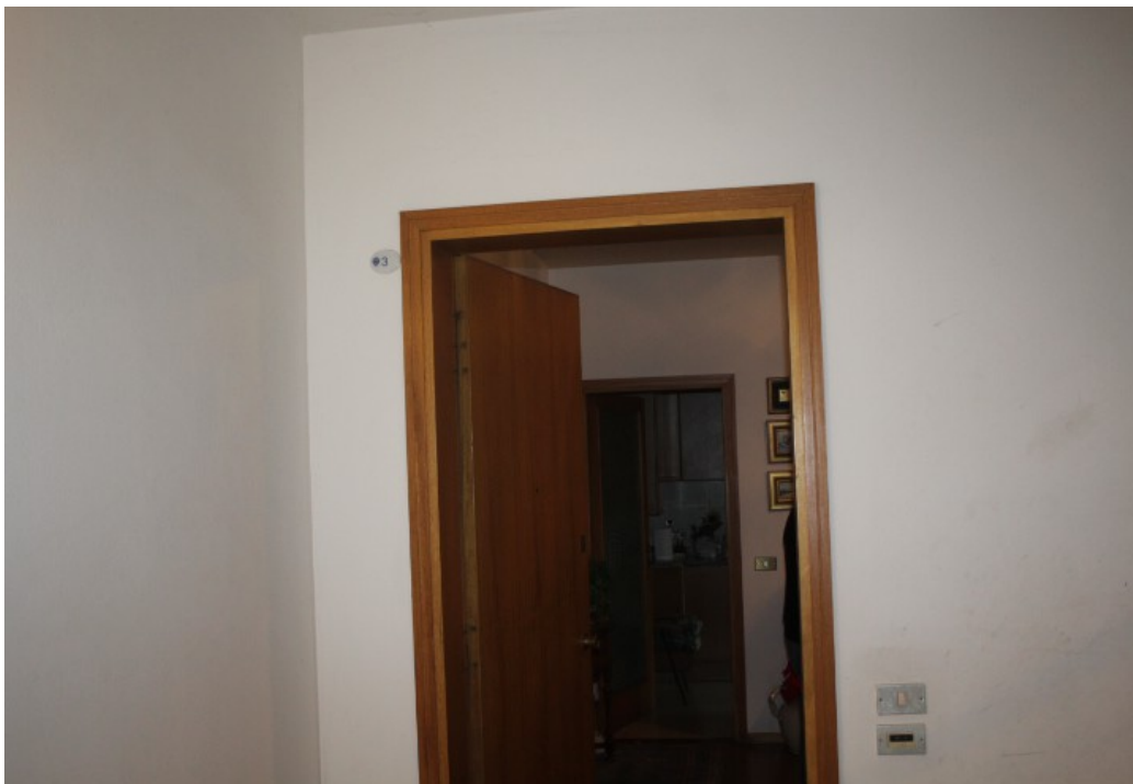
portoncino di ingresso appartamento al piano primo
