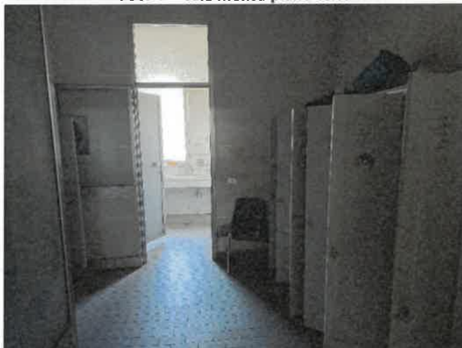
Foto 8 – spogliatoi piano terra
