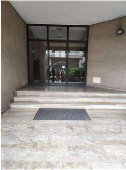
Vista ingresso al vano scala
