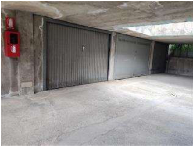
Vista corsello autorimesse
