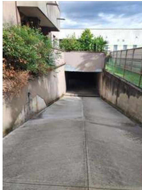
Rampa d'accesso alle autorimesse
