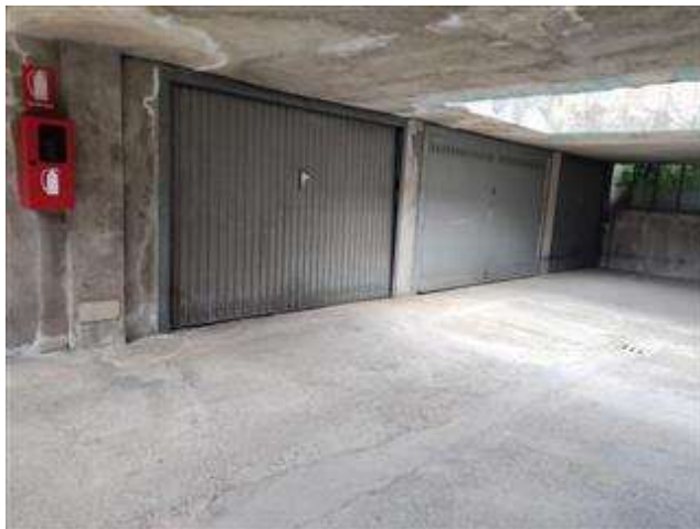
Vista corsello autorimesse
