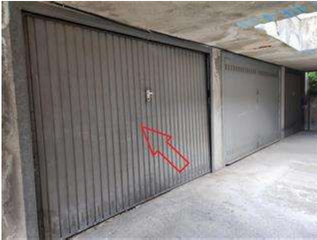
Corsello box con individuazione dell'unità di pertinenza
