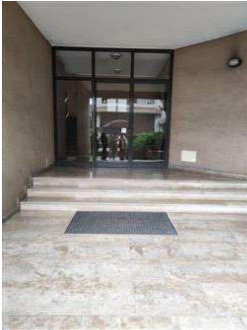
Vista ingresso al vano scala
