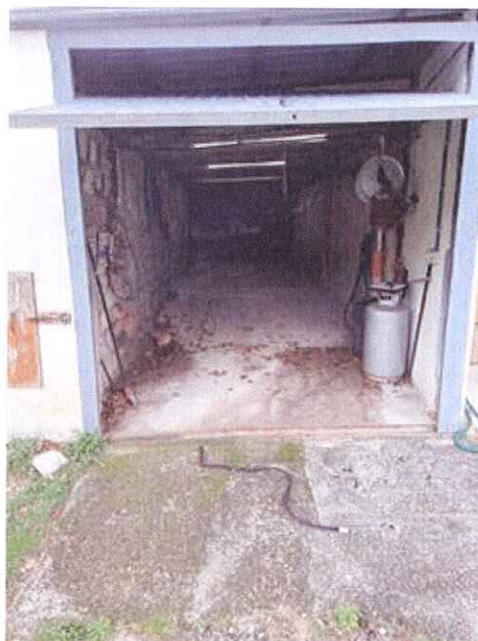
Locale Ripostiglio al Piano Primo Sottostrada
