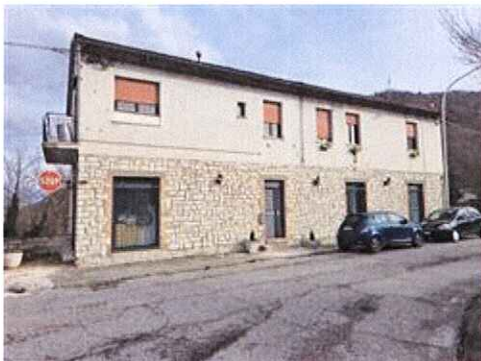
Fronte su via Monte Catria
