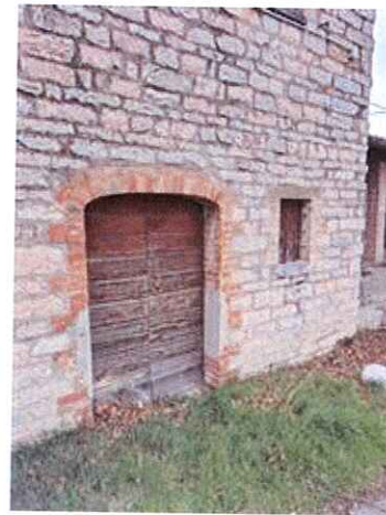
accesso alla cantina
