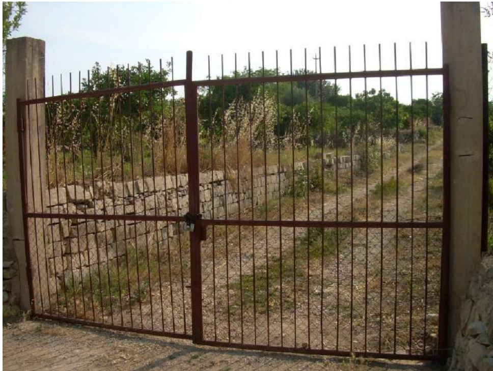
Figura 1: CANCELLO D'INGRESSO AL LOTTO 3.
