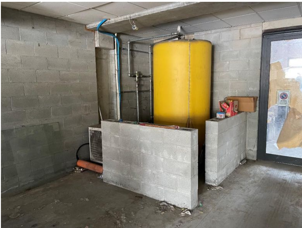
Piano terra - Autorimessa (foto 4)
