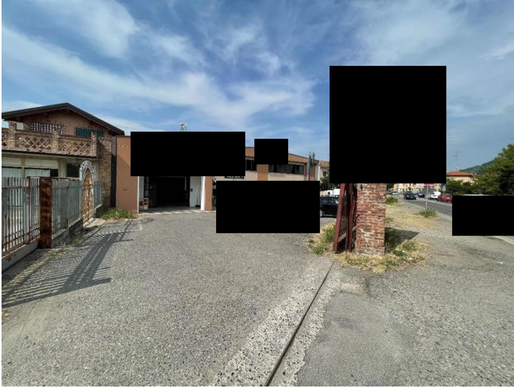
Fabbricato - Vista da strada (foto 1)
