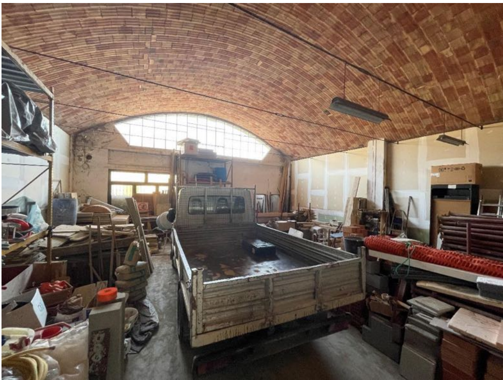
Piano terra - Magazzino (foto 2)
