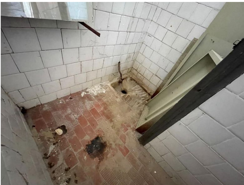
Piano terra – Ripostiglio 3
