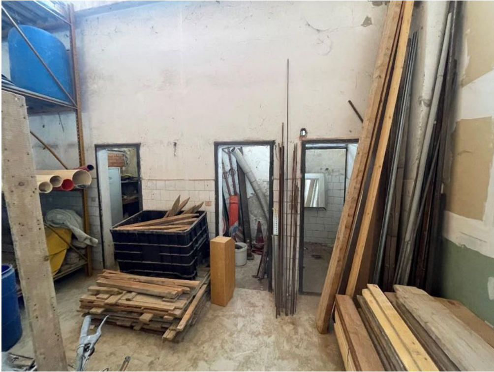
Piano terra - Magazzino su ripostigli
