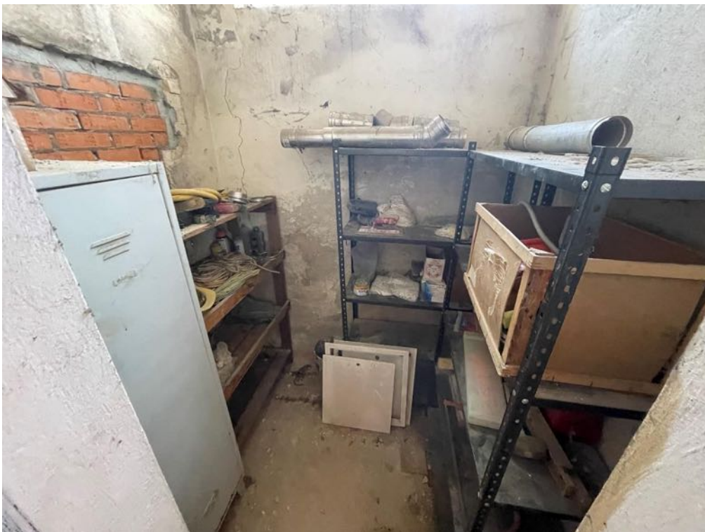
Piano terra - Ripostiglio 1
