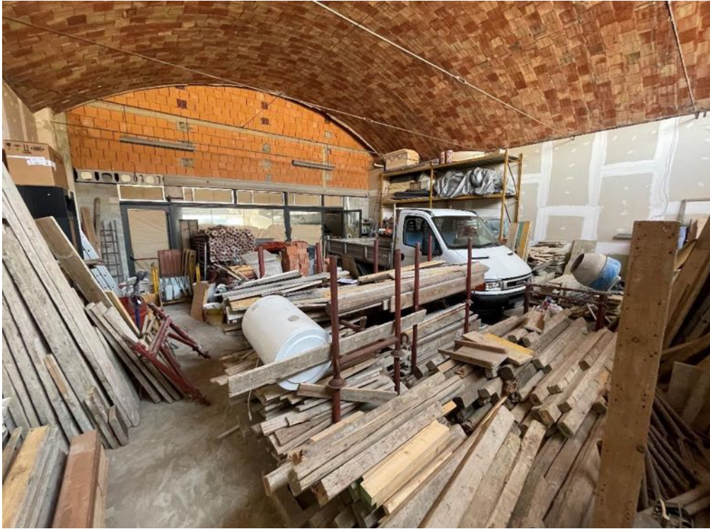
Piano terra - Magazzino (foto 1)
