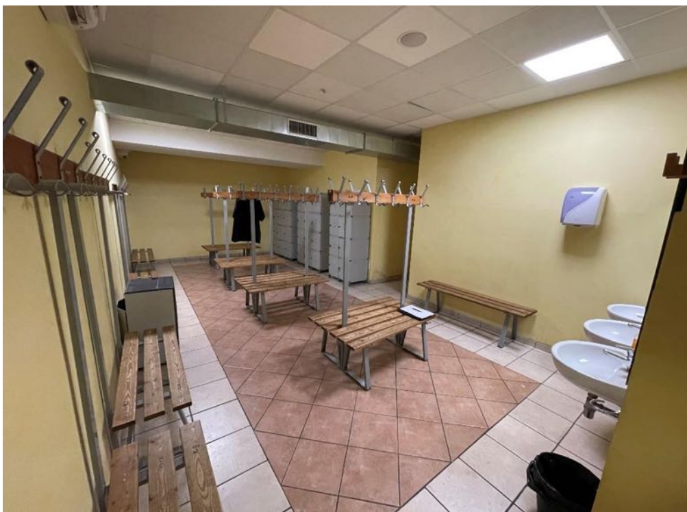
Piano terra - Spogliatoio uomini (foto 1)
