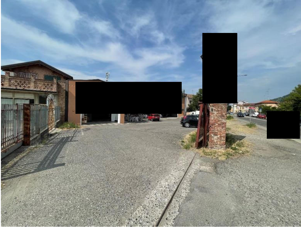
Fabbricato - Vista da strada (foto 1)
