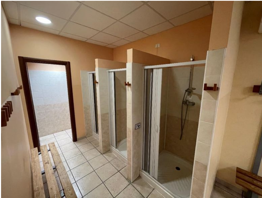
Piano Terra - Spogliatoio donne - Docce
