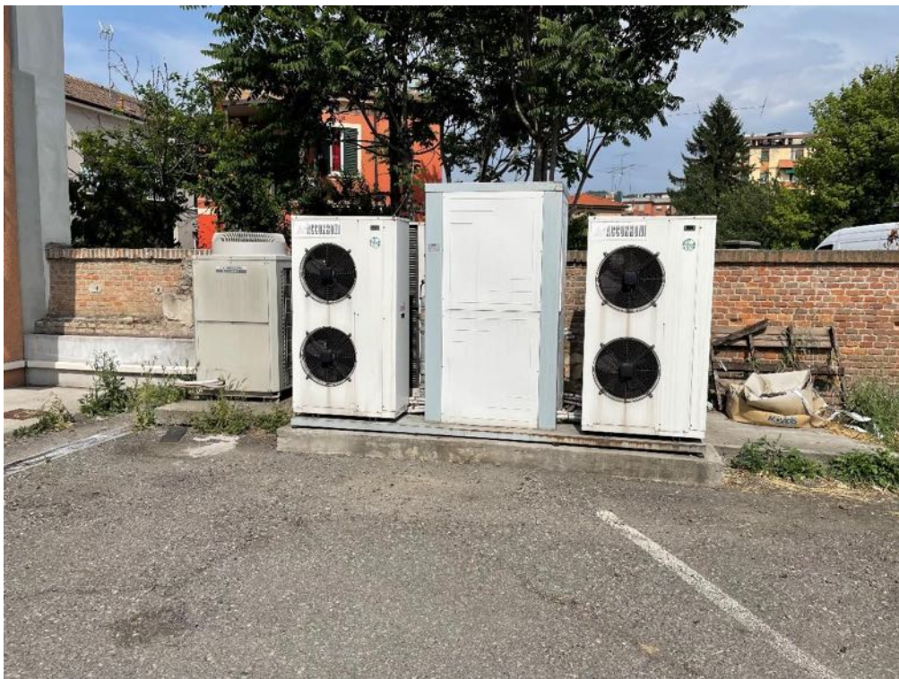
Impianto - Vista da area di parcheggio
