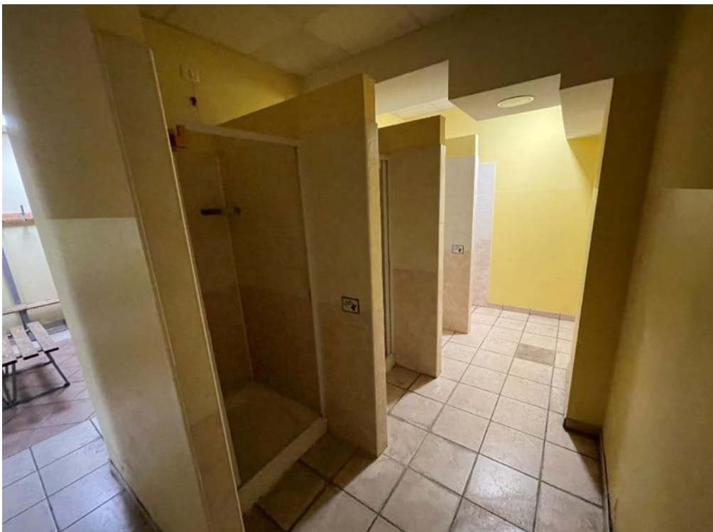
Piano terra - Spogliatoio uomini - Docce (foto 1)
