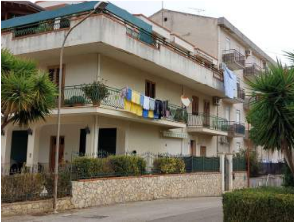
Foto 7° - Prospetto su Via Vincenzo Ferro.
