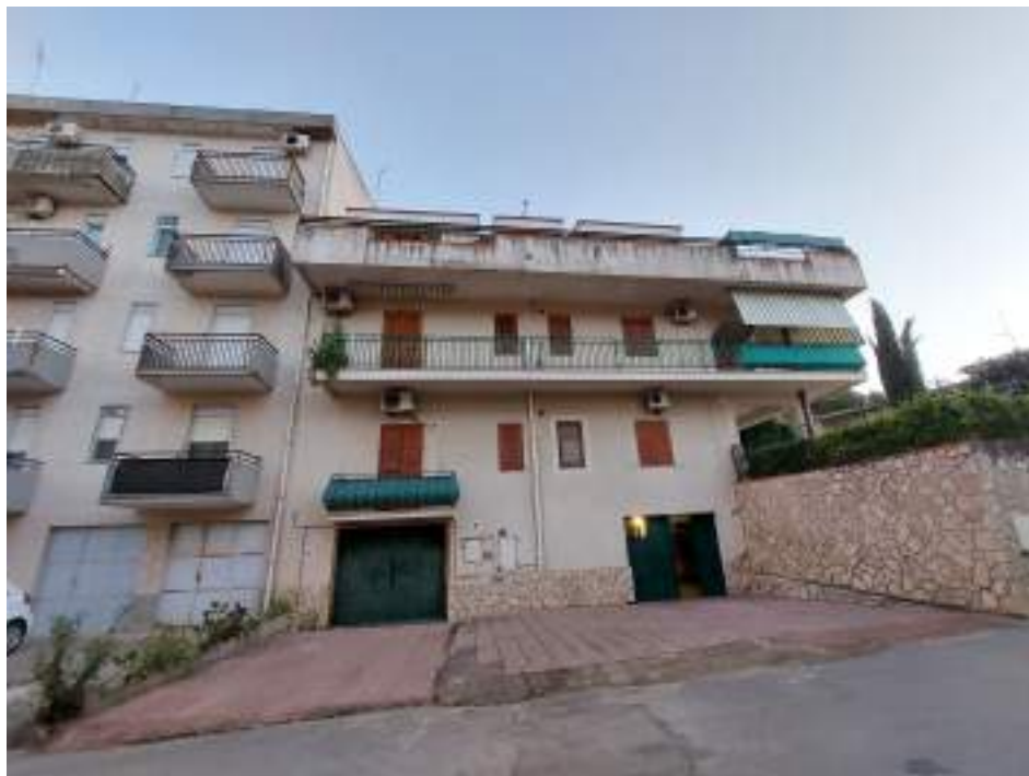
Foto 5° - Prospetto su Via Ballo Rocco.
