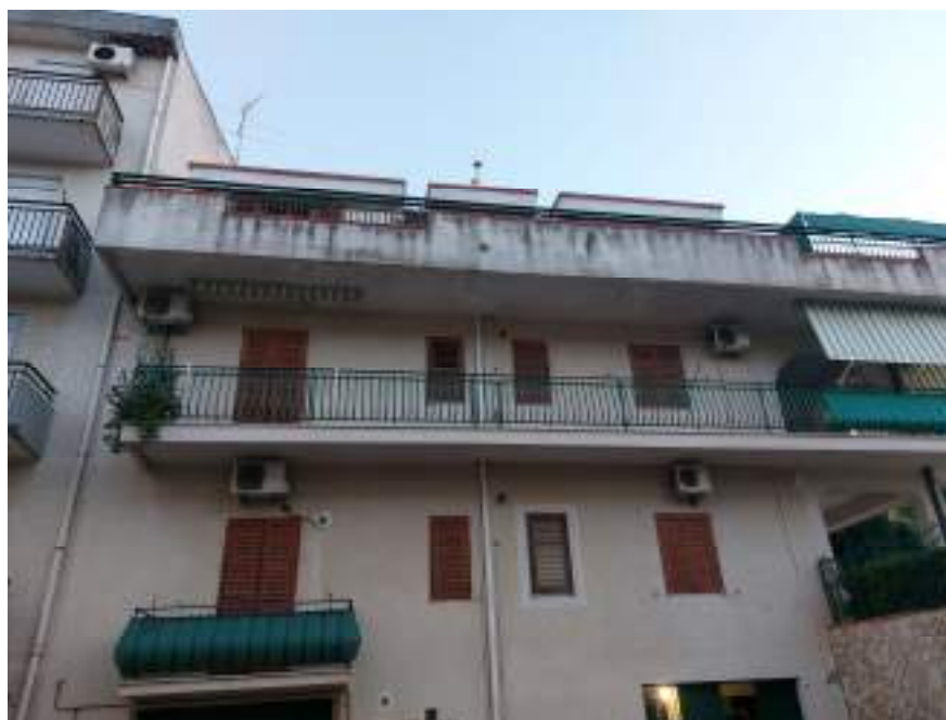
Foto 6° - Particolare del prospetto su Via Ballo Rocco.
