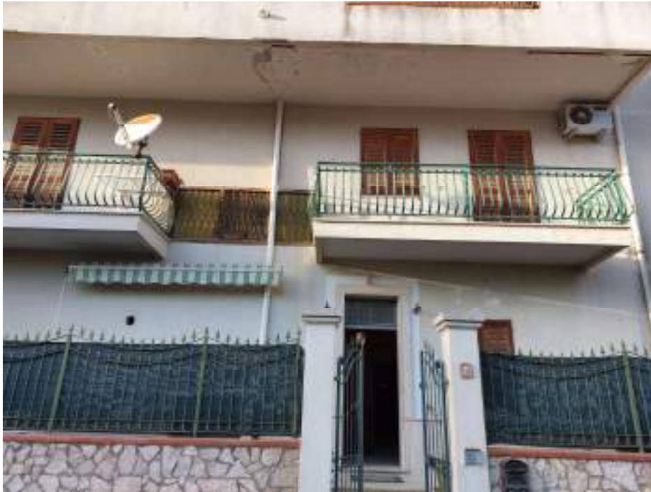
Foto 10° - Particolare ingresso dall'esterno del Sub 1, sul prospetto su Via Vincenzo Ferro.
