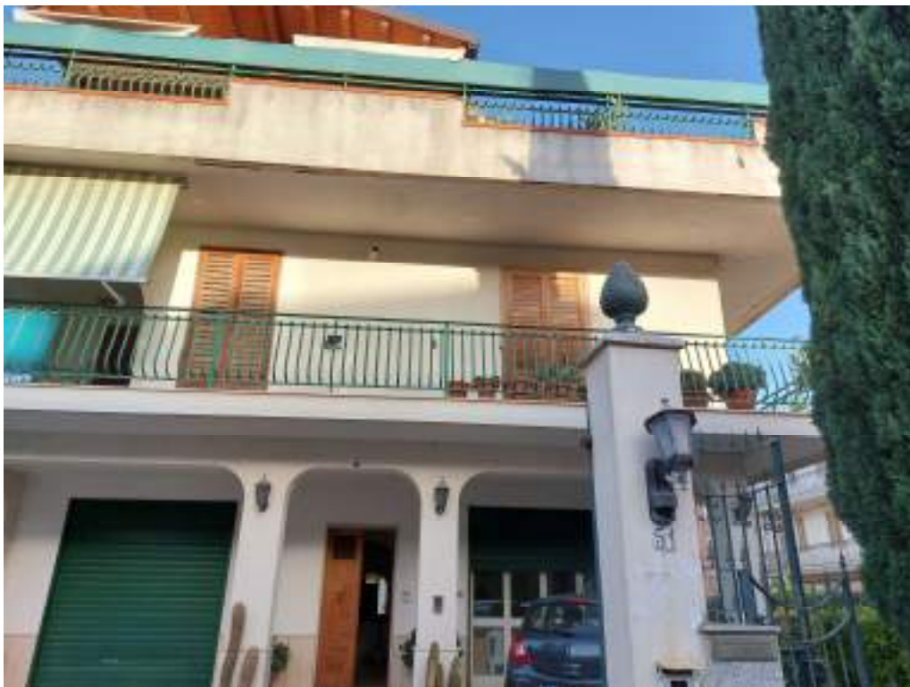
Foto 3° - Particolare dell'ingresso principale e del piano primo dell'immobile.
