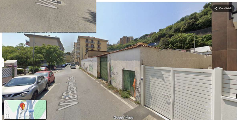
Diverse prospettive della pubblica "Via Gaeta" dalla quale l'immobile presenta plurimi accessi, sia carrabili che pedonali, a servizio del Lotto Unico e del complesso edilizio di cui fa parte. (fonte: Google maps).
