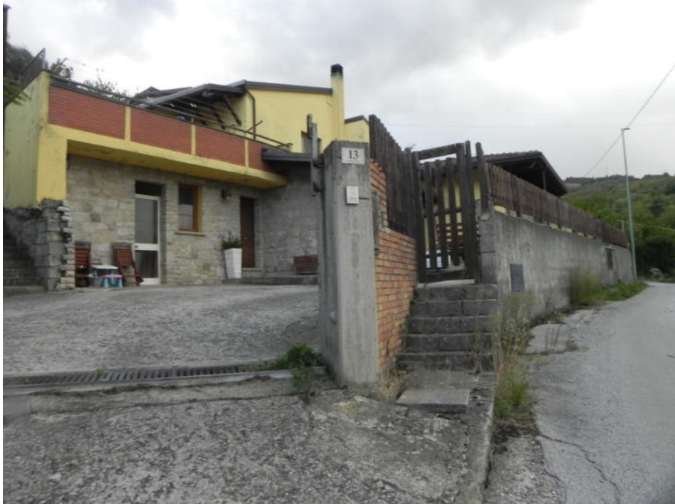
Piazzale antistante al piano seminterrato
