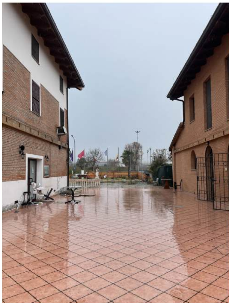
Area esterna tra Edificio A ed Edificio B
