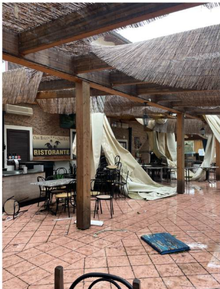
Ex ristorante addossato all'Edificio B
