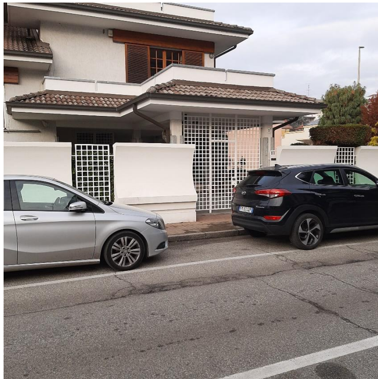
Figura 4 DETTAGLIO INGRESSO DA VIA RODI
