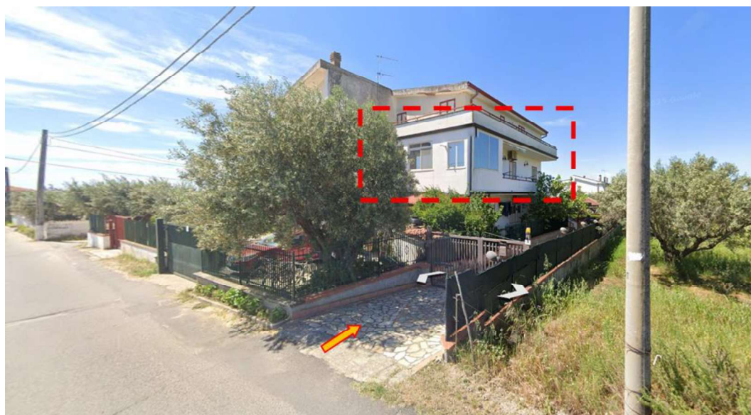
Fig. 7 – Foto fabbricato -Ingresso all'appartamento di stima.
