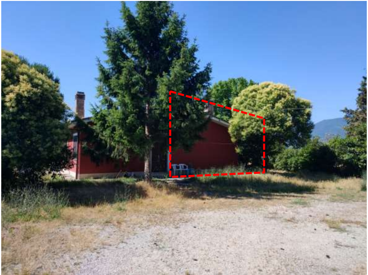
FOTO 1 – Esterno Lato Nord ( Sub. 1)
