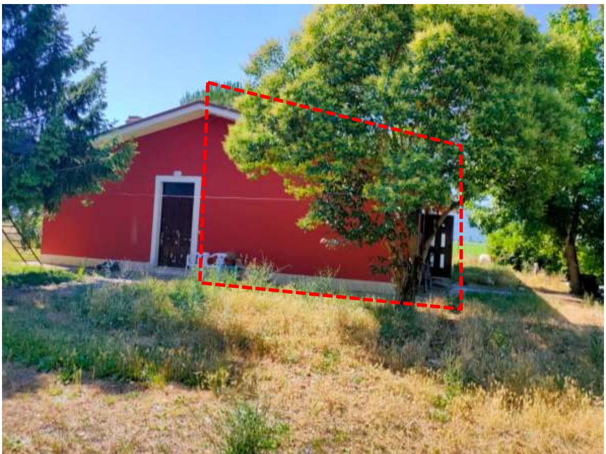
FOTO 2 – Esterno Lato Nord ( Sub. 1)
