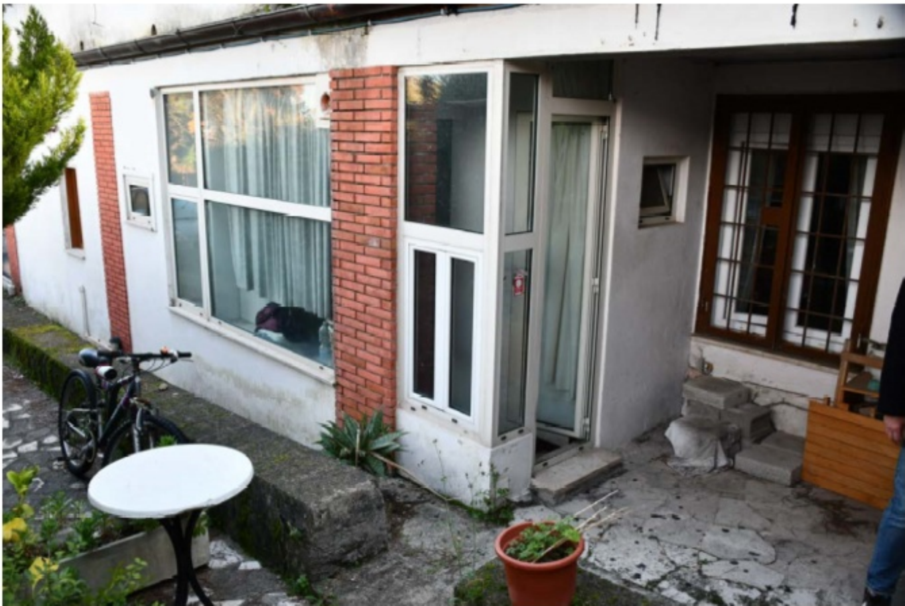
Particolare della lavanderia
