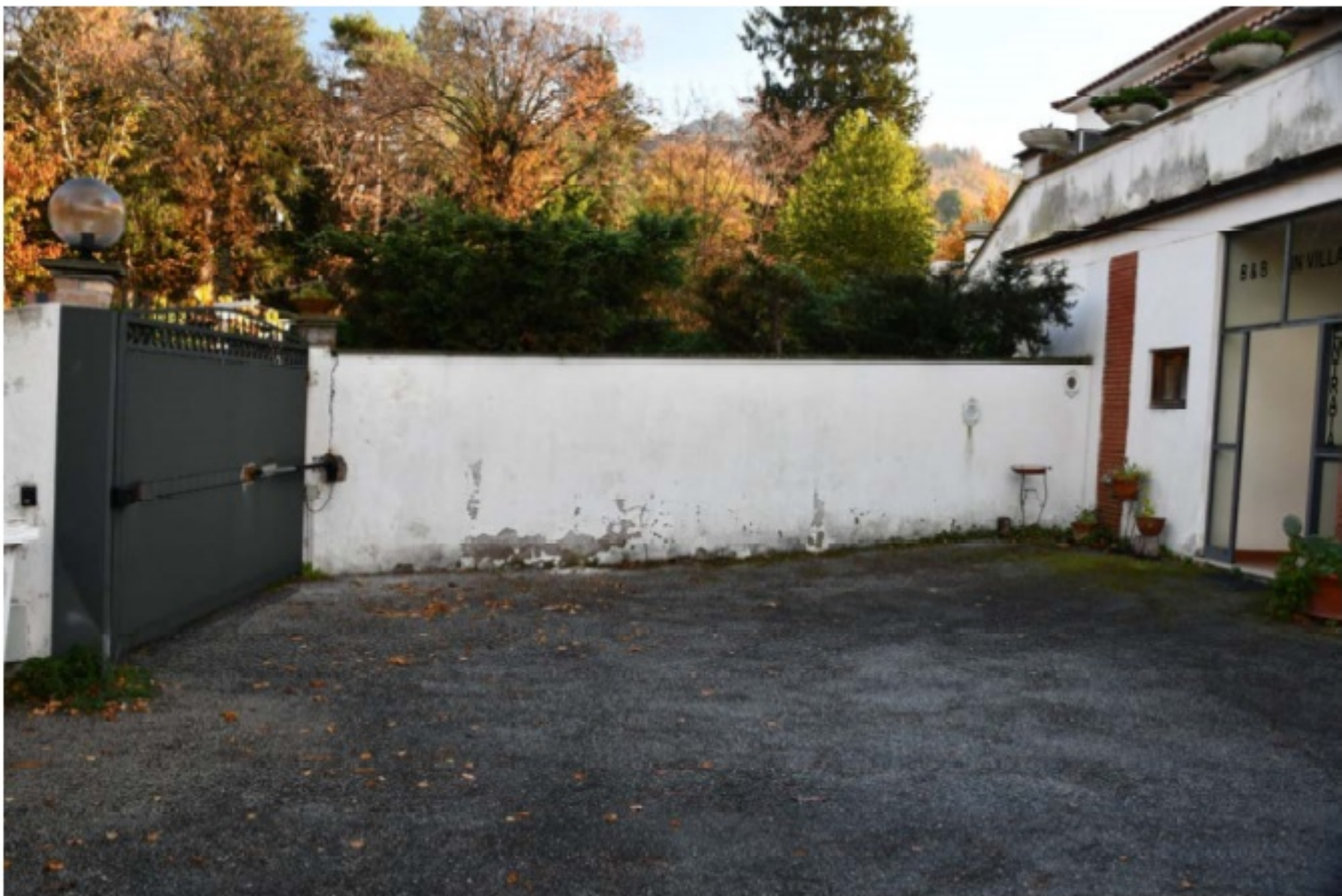
Particolare del cancello motorizzato
