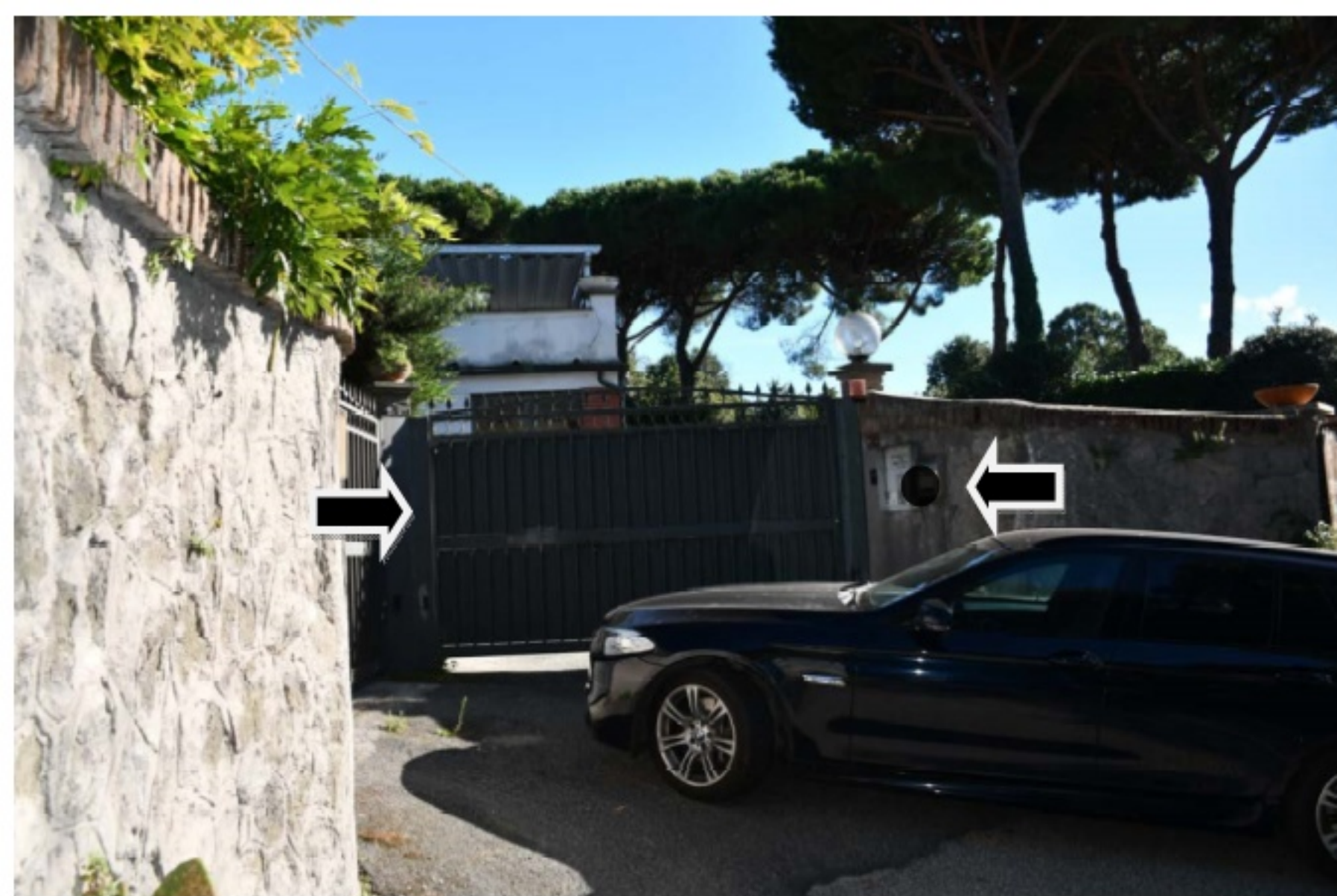
Particolare dell'ingresso al complesso immobiliare.
