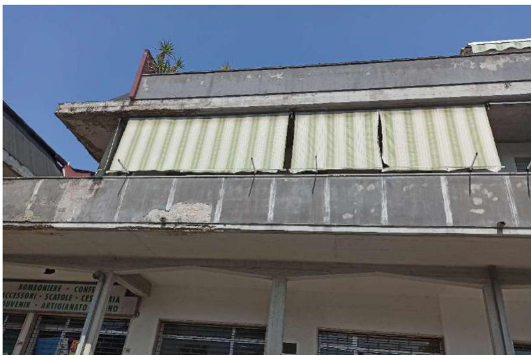
Vista esterna – particolare
