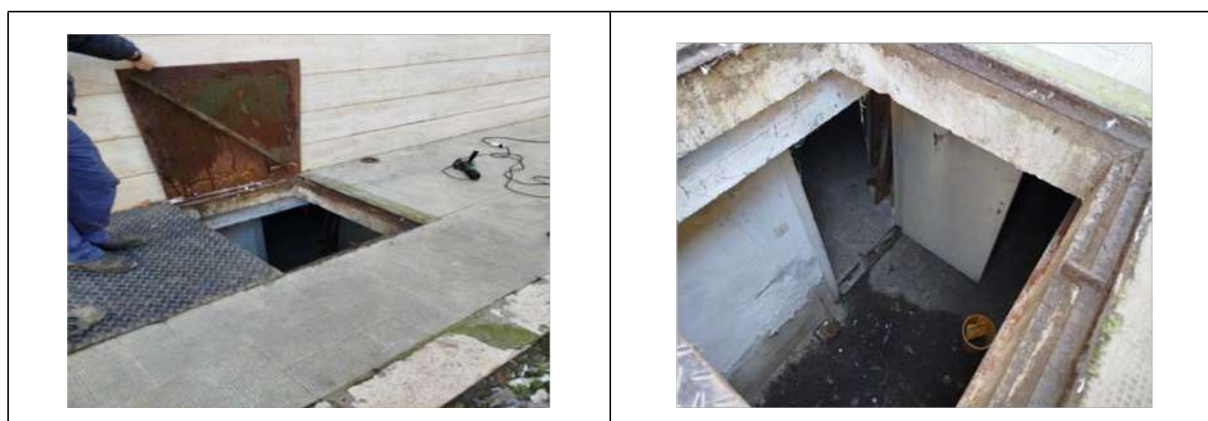
Figura 1. botola utilizzata per accedere all'unità immobiliare
