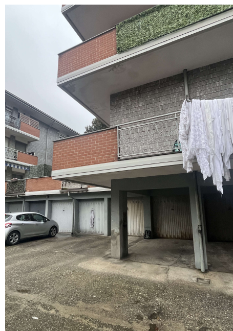
19 - 20. Riprese fotografiche dell'autorimessa al piano seminterrato
