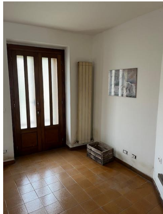
PORTA SU CORTE LATO NORD
