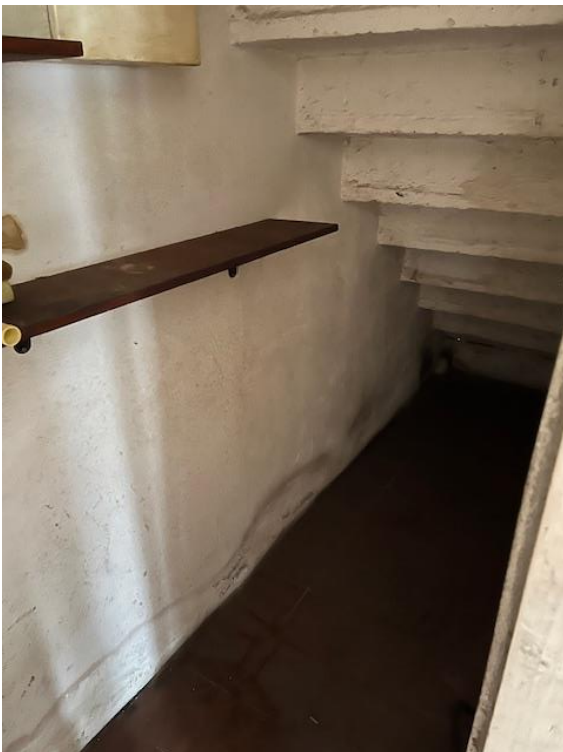
PARTICOLARE RIPOSTIGLIO A
