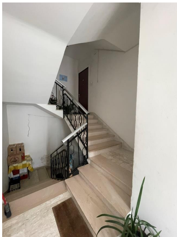
Vista vano scala da ingresso piano terra
