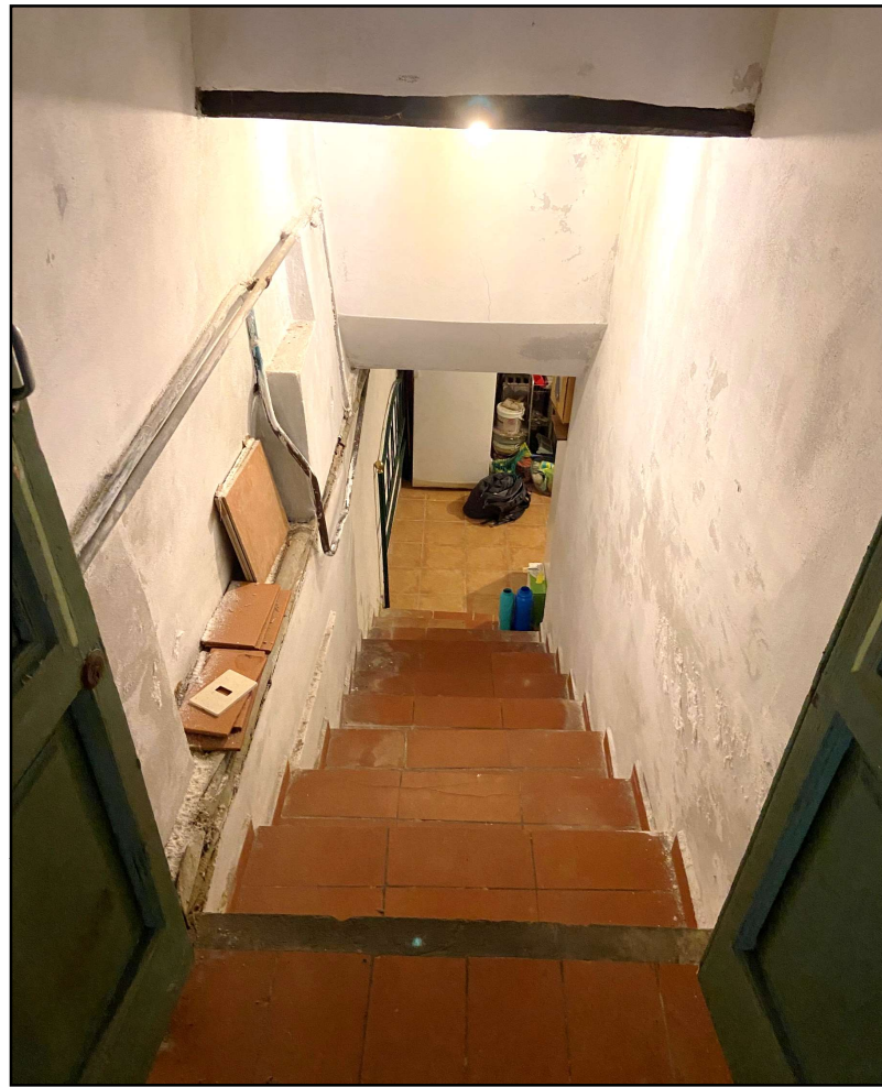
scala di accesso alla cantina
