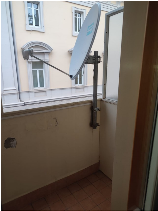
Altro balcone accessibile da una stanza da letto
