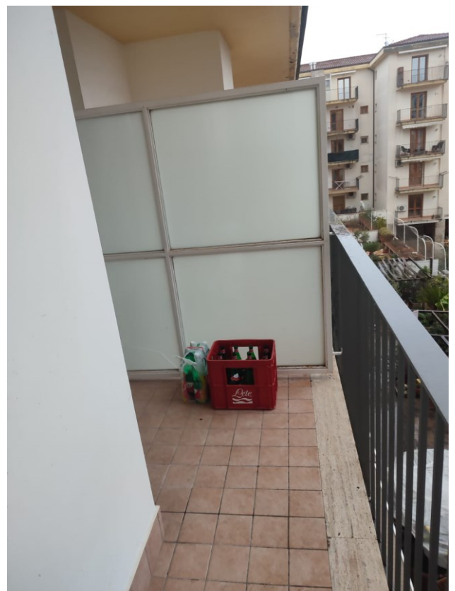
Balcone accessibile dal soggiorno
