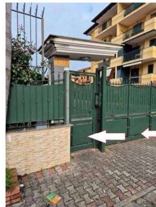
Figura 7 accesso pedonale e carrabile al cortile comune del Condominio Parco Arcobaleno 3 – Edificio A/13 in Orta di Atella
