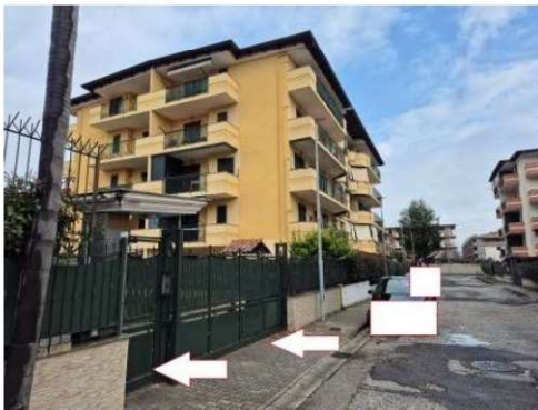
Figura 3 facciata sud/est del fabbricato con accesso pedonale e carrabile al cortile comune del Condominio Parco Arcobaleno 3 – Edificio A/13 in Orta di Atella
