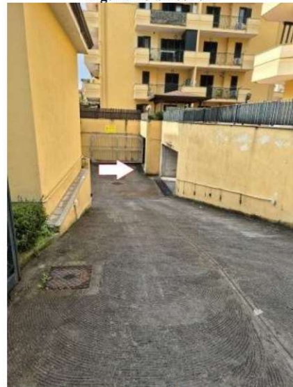
Figura 25 rampa carrabile del piano interrato del Condominio Parco Arcobaleno 3 in Orta di Atella alla via Clanio n.33
