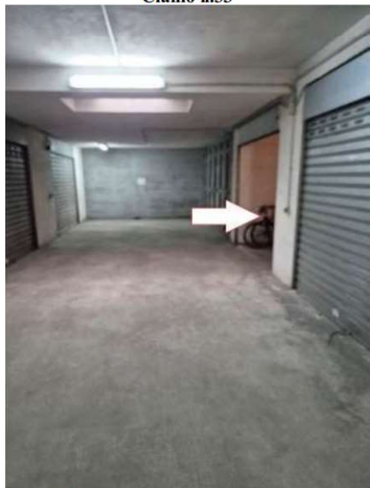
Figura 26 accesso al box auto al piano interrato
