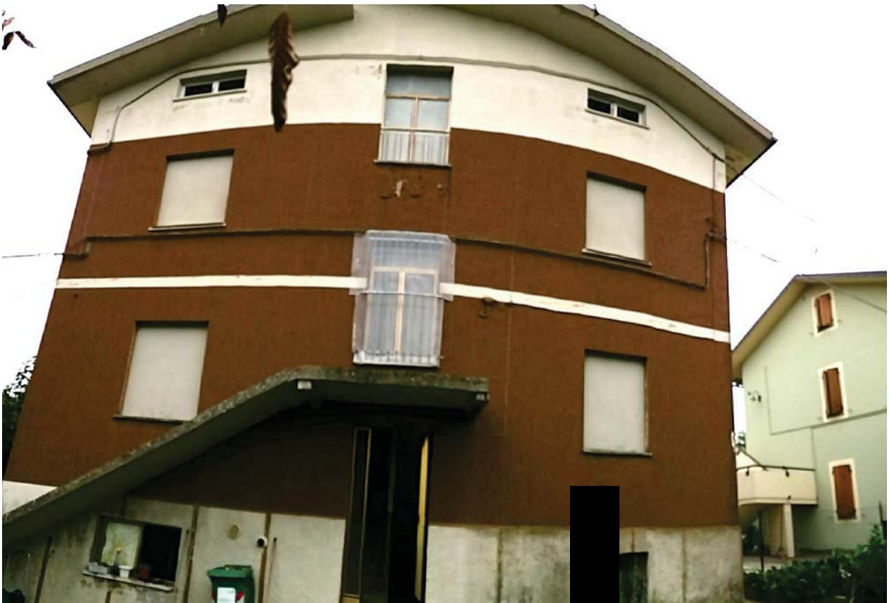
Figura 2 – EDIFICIO VISTO DAL RETRO - LATO NORD
