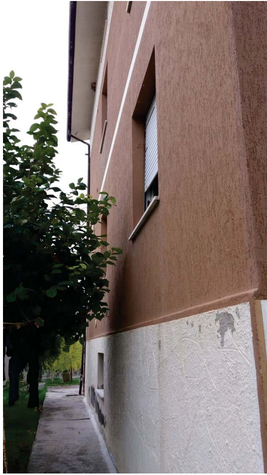
Figura 5 EDIFICIO - LATO EST
