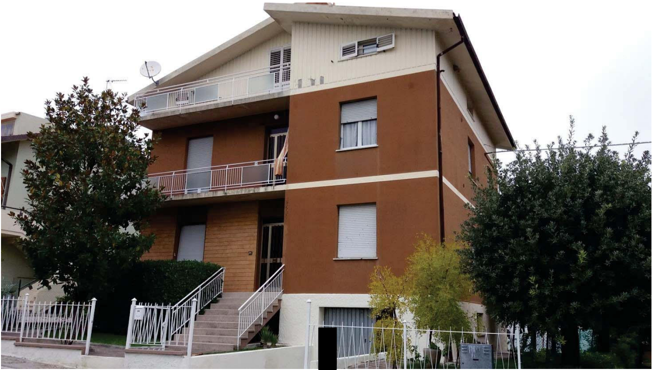
Figura 1 – EDIFICIO VISTA DA VIA LANCISI- LATO SUD
