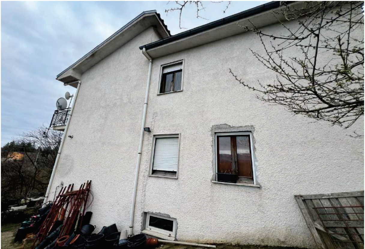
FOTO 4: Veduta esterna prospetto nord-ovest
