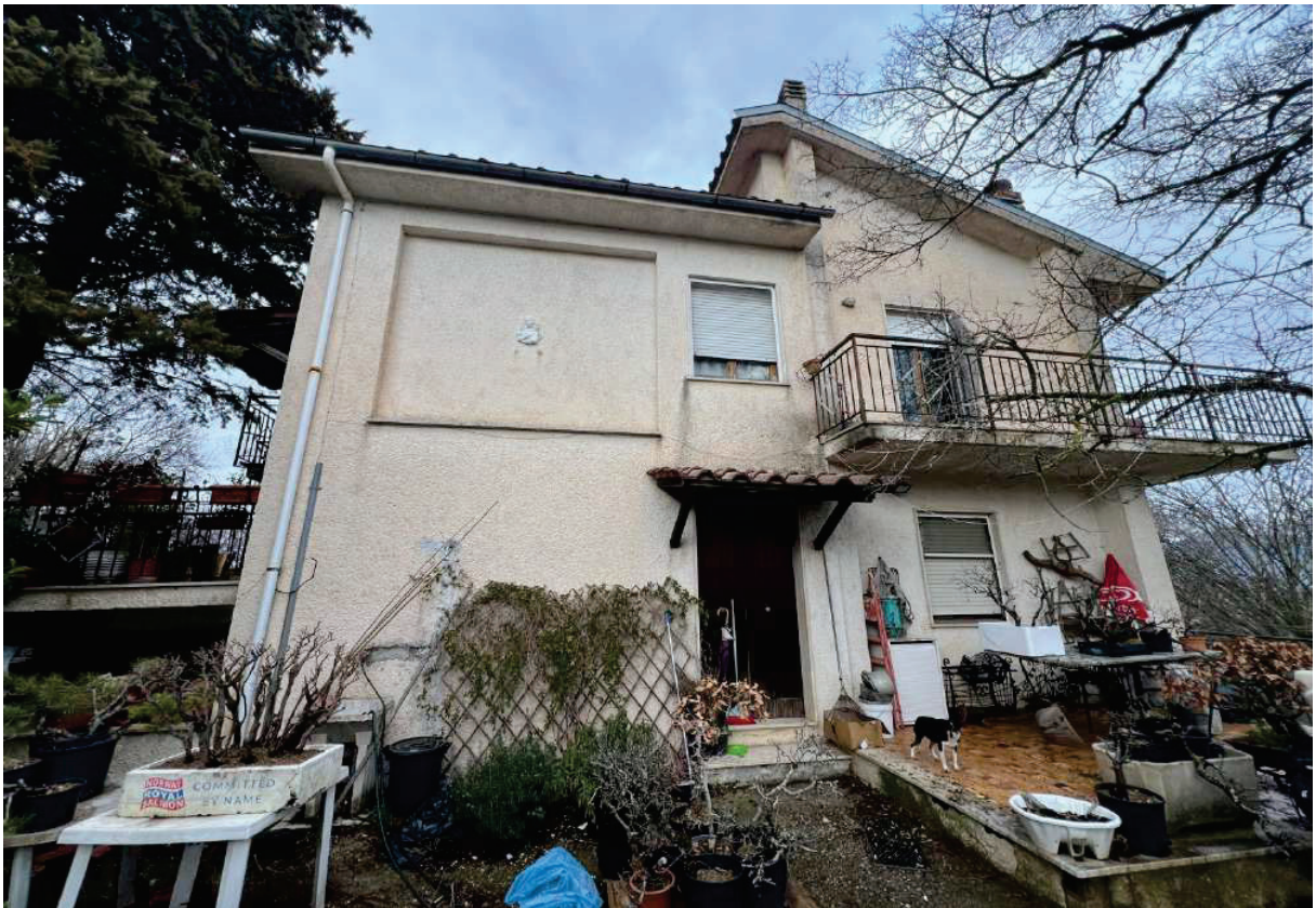
FOTO 2: Veduta esterna prospetto sud-est
