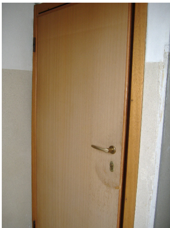
Porta di accesso al piano cantinato (P.S1)
