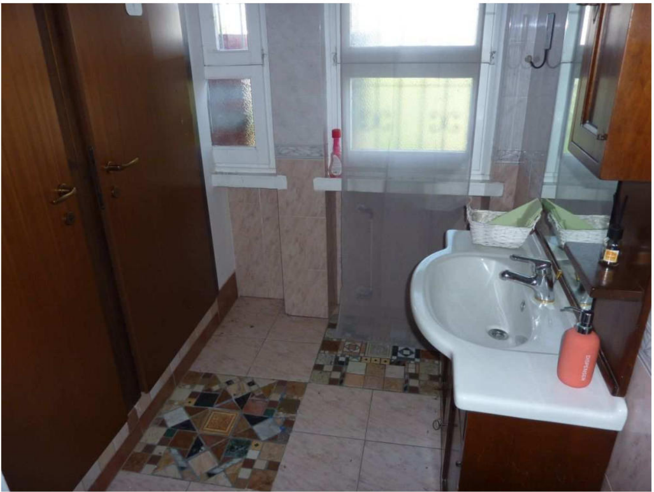
34. Disimpegno/bagno del locale servizi igienici
