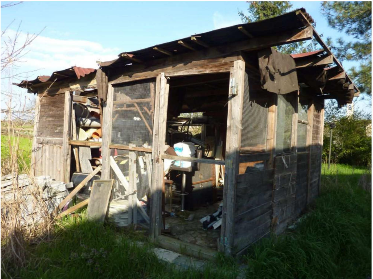
12. Particolare dello stato della “voliera”
