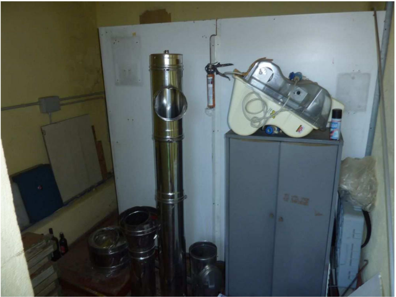
38. Interno del locale caldaia/deposito con accesso dal fronte Nord (caldaia non presente)
