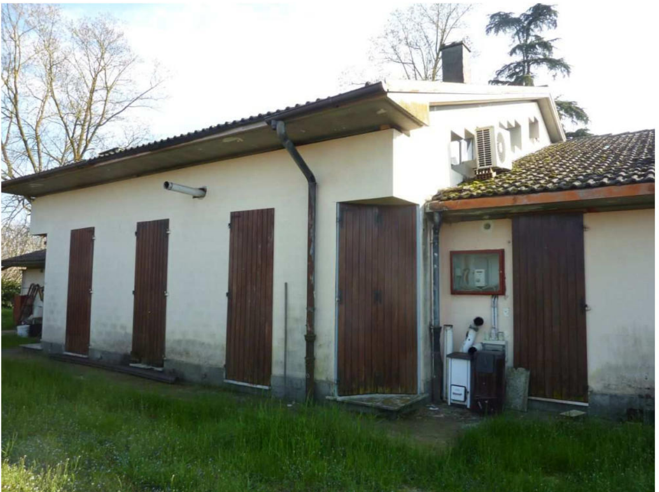
5. Fronte Nord degli immobili
