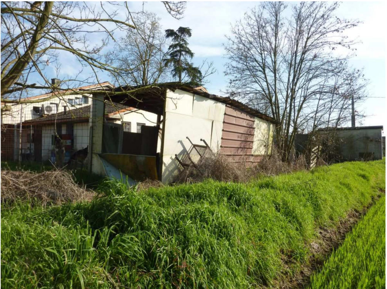
8. Fronte Ovest della baracca ubicata nello spigolo Nord-Ovest
