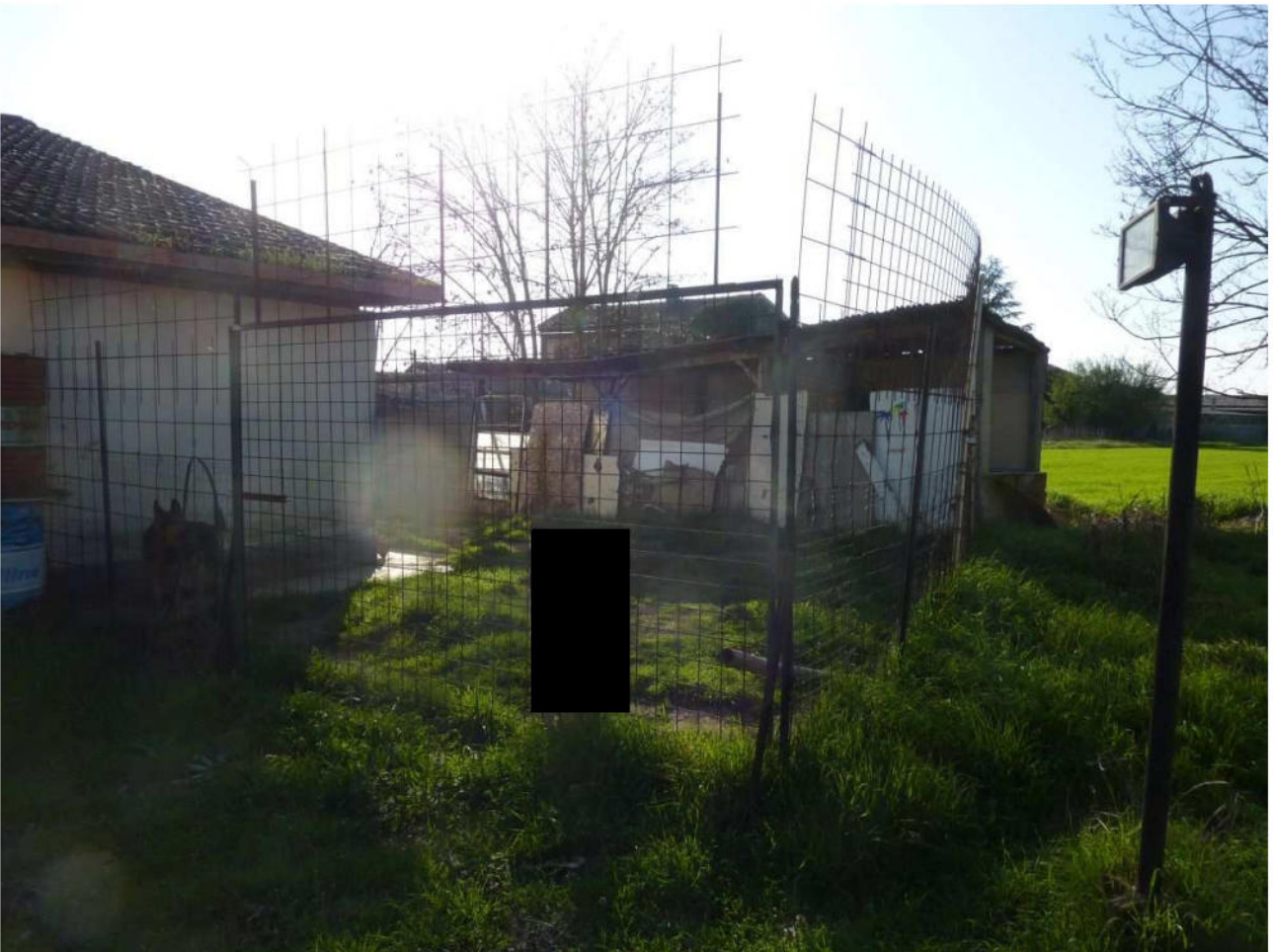
7. Fronte Est della baracca ubicata nello spigolo Nord-Ovest
