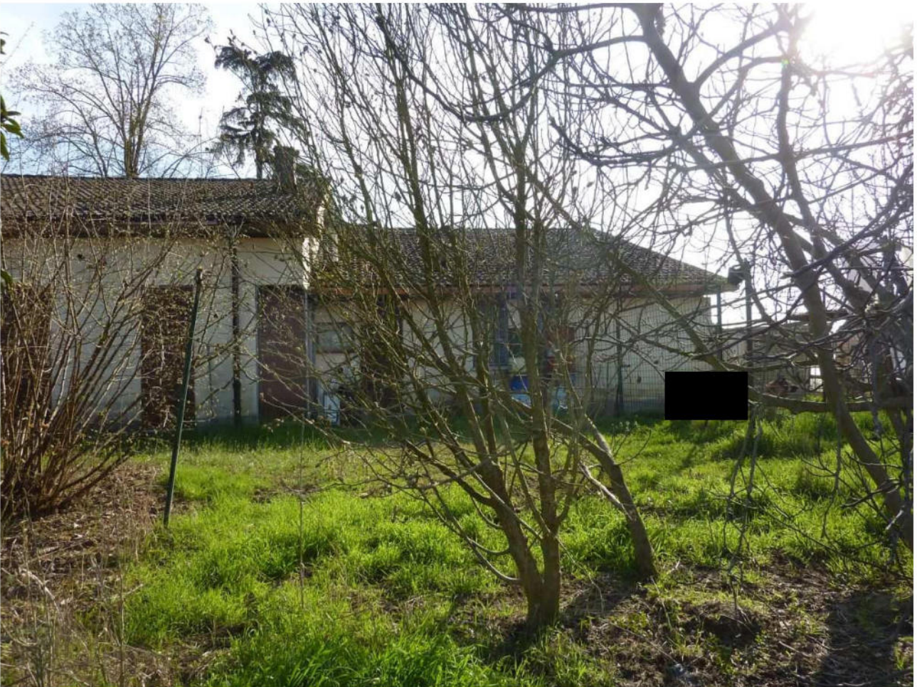
6. Fronte Nord degli immobili
