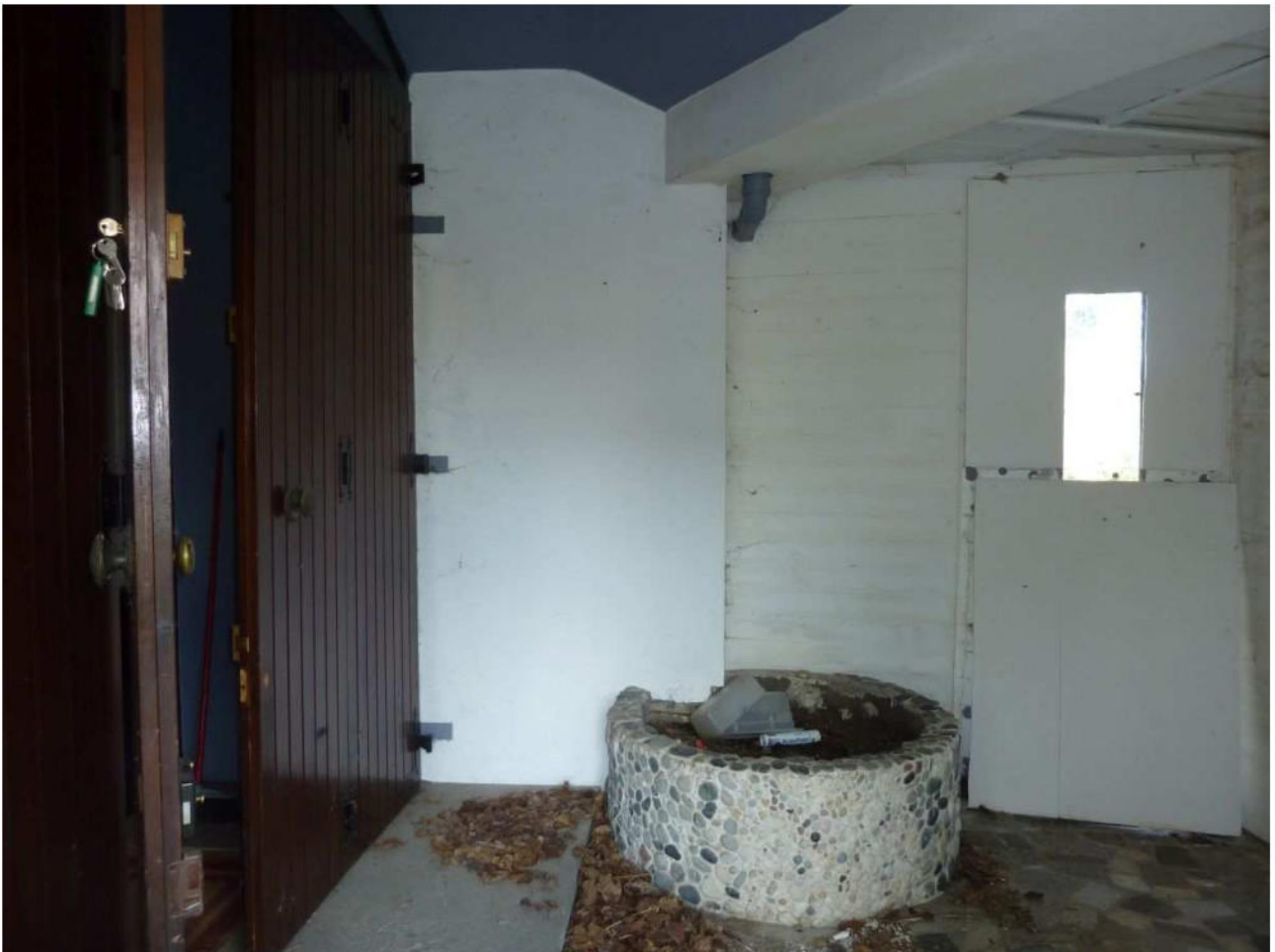
15. Ingresso coperto al Ristorante/Bar dal fronte Est
