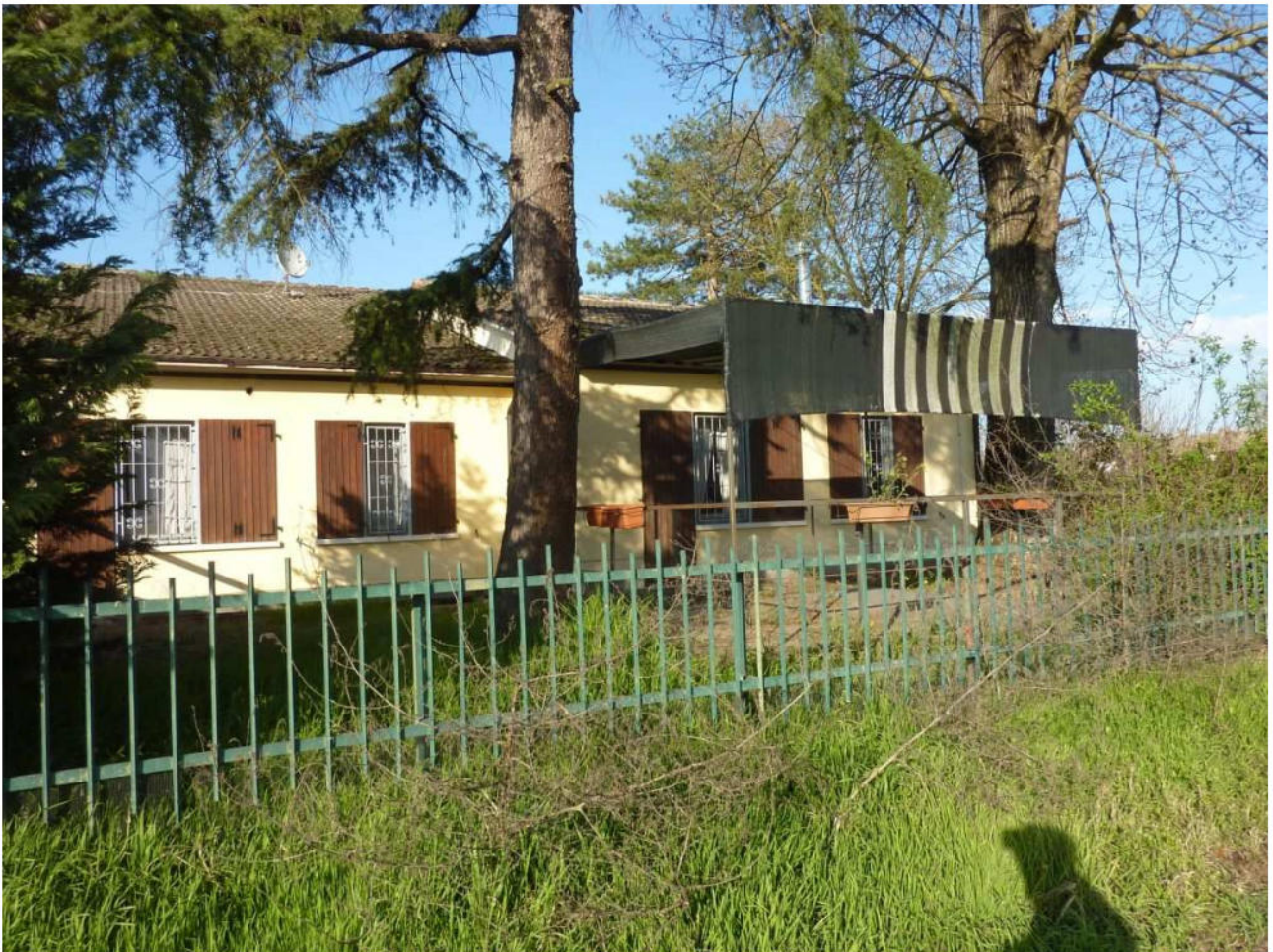
2. Parte degli immobili dal fronte strada
