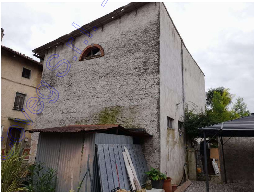
facciate laterale e posteriore
