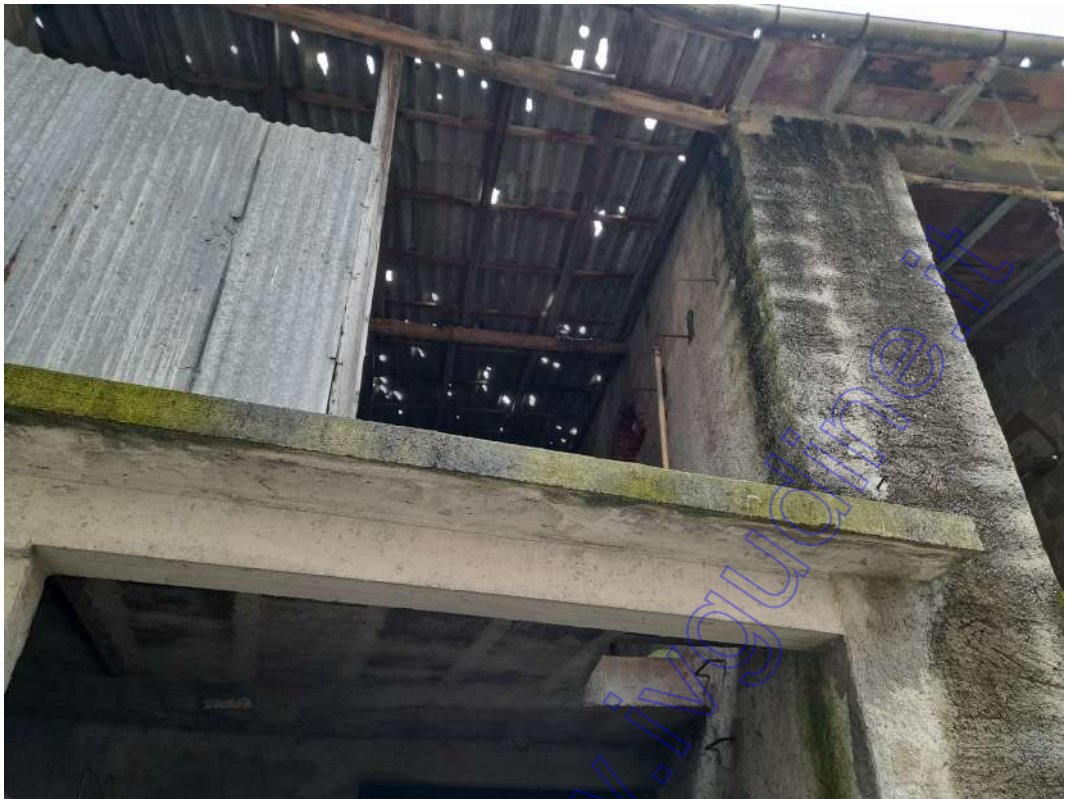
particolare della copertura forata
