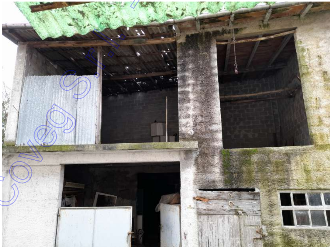
Interno del 1° piano – ex fienile
