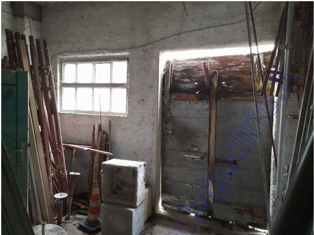
interno - deposito con accesso dalla corte
