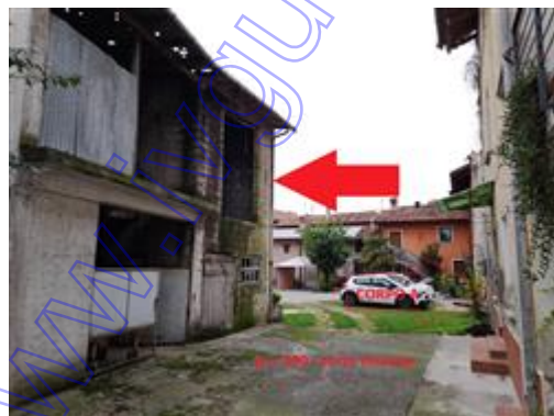
vista fabbricati prospicienti e corte comune
