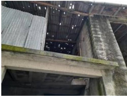
particolare copertura forata - e pioli per accesso al 1°p.
