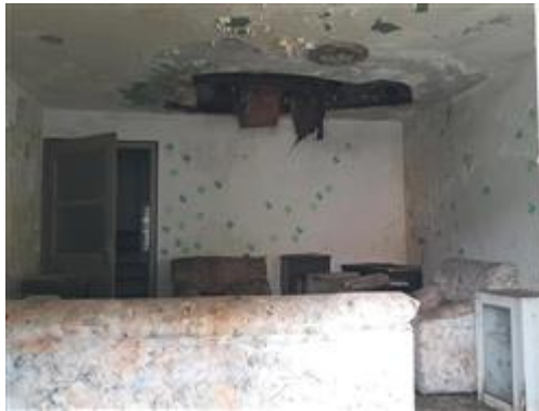
Interno fabbricato - sala da pranzo
