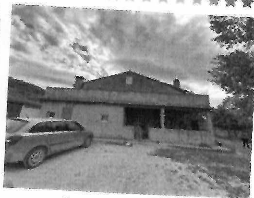
Esterno Fabbricato residenziale
