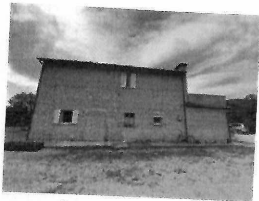
Esterno Fabbricato residenziale
