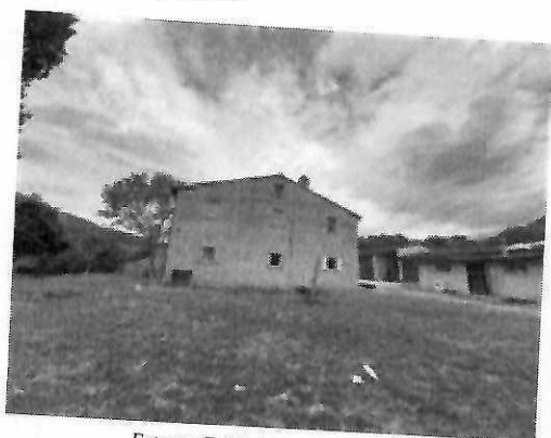
Esterno Fabbricato residenziale
