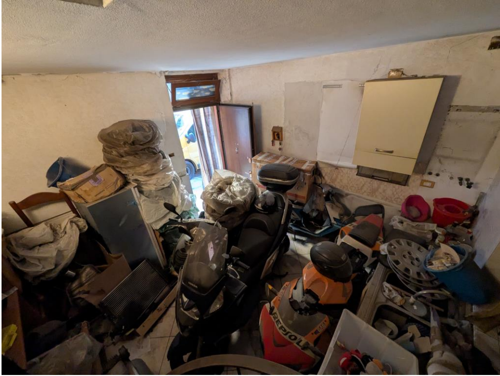
Foto 5 – locale piano terreno
