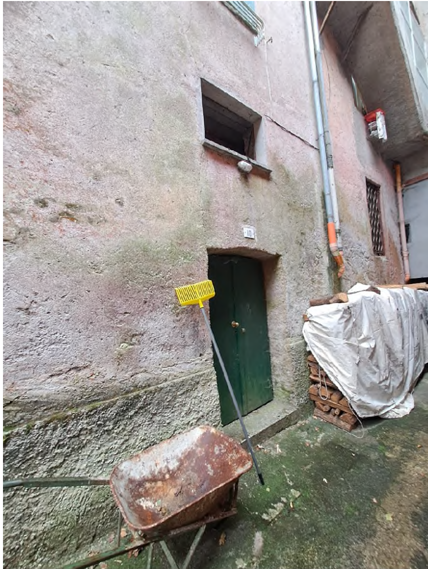
Ingress cantina da via Al Mulino
