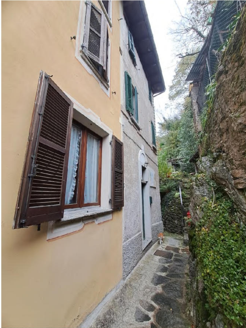
Vista da via Trebisonda
