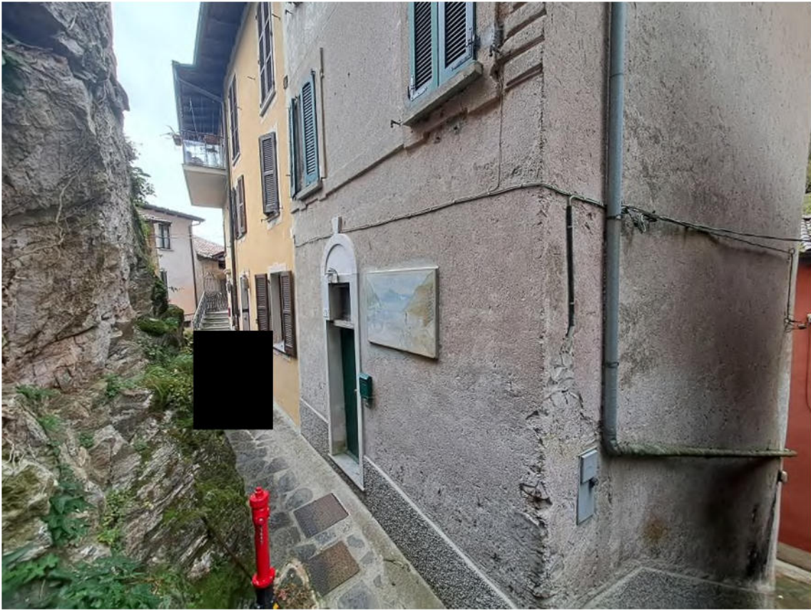
Vista da Via Trebisonda
