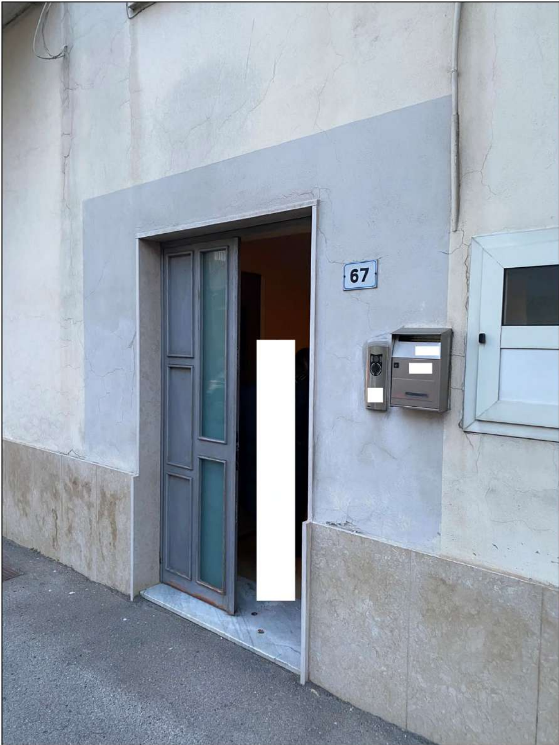
FIGURA 3. INGRESSO DA VIA CIRCUMVALLAZIONE N. 67.
