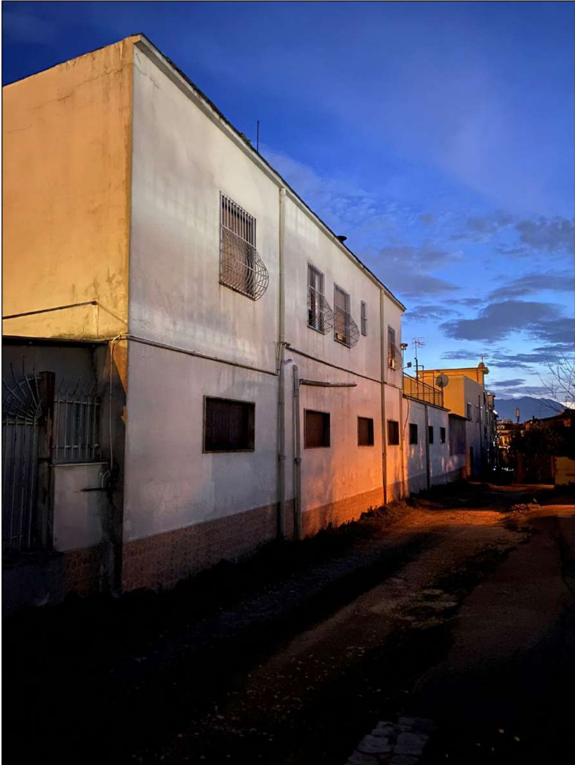
FIGURA 2. PROSPETTO NORD-OVEST FABBRICATO.
