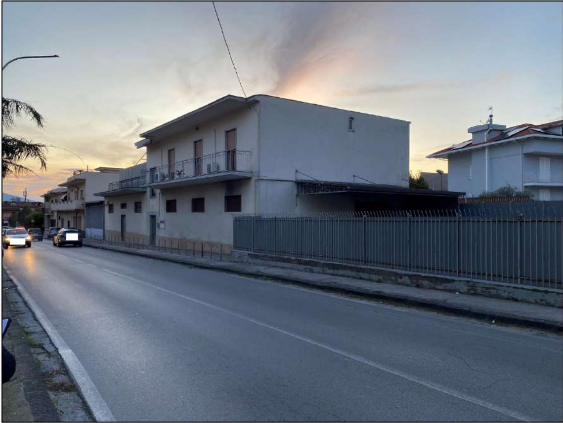
FIGURA 1. PROSPETTO SUD-EST FABBRICATO.
