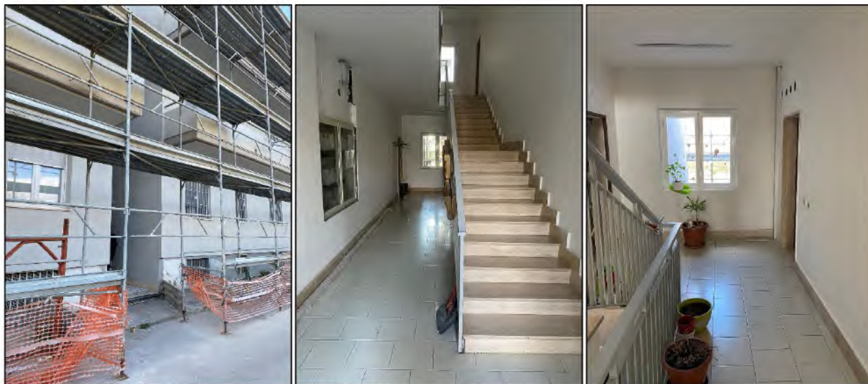
FIGURA 4. FABBRICATO A, SCALA C.
