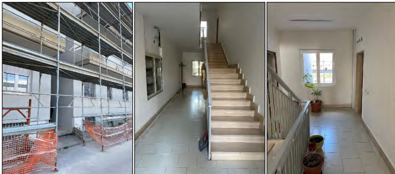
FIGURA 11. FABBRICATO A, SCALA C.
