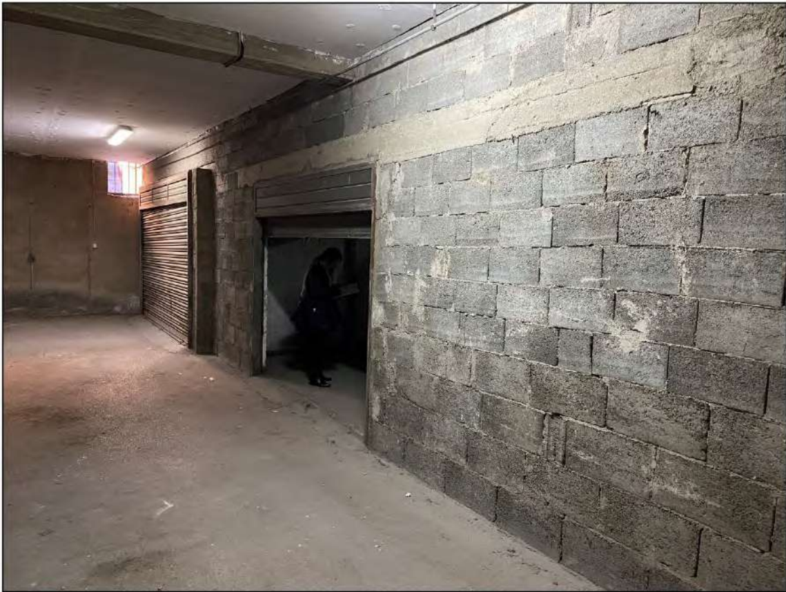
FIGURA 26. INGRESSO UNITÀ IMMOBILIARE 15/202/132.
