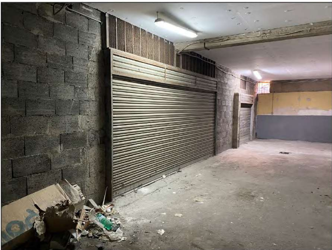
FIGURA 27. ULTERIORE INGRESSO SUL RETRO.
