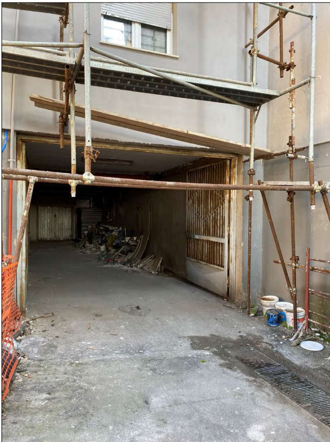
FIGURA 25. ACCESSO PIANO SEMINTERRATO.
