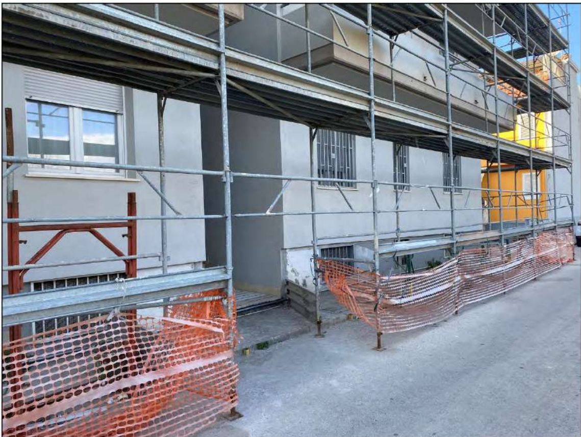
FIGURA 4. ACCESSO EDIFICIO A - CORPO SCALA C.
