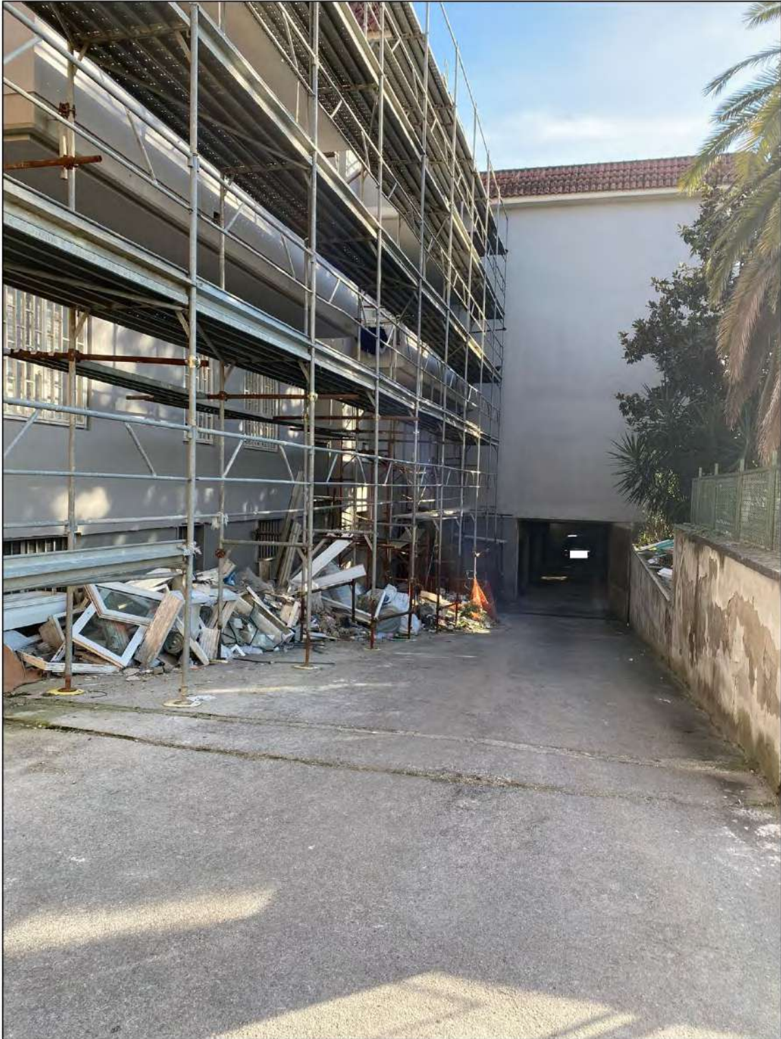
FIGURA 24. RAMPA DI ACCESSO PIANO SEMINTERRATO.
