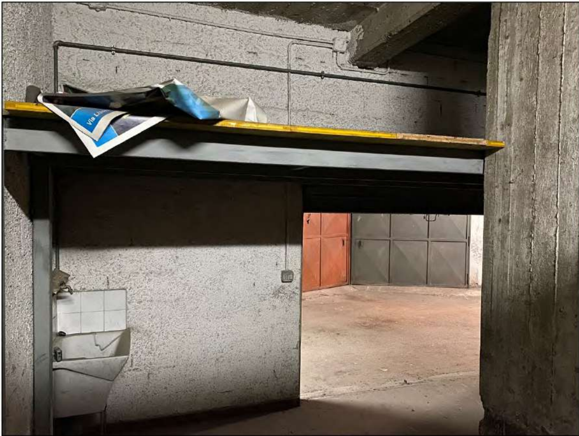
FIGURA 30. INTERNO UNITÀ (PARTICOLARE SOPPALCO)
