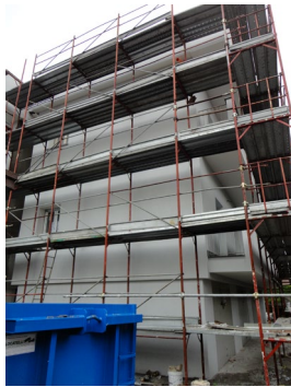
Vista esterna dell'immobile
