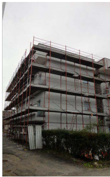
Vista esterna dell'immobile
