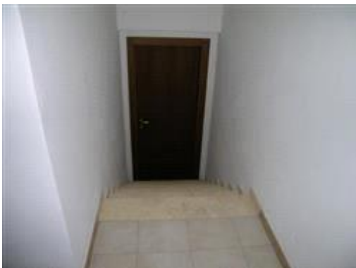
scale condominiali - accesso seminterrato
