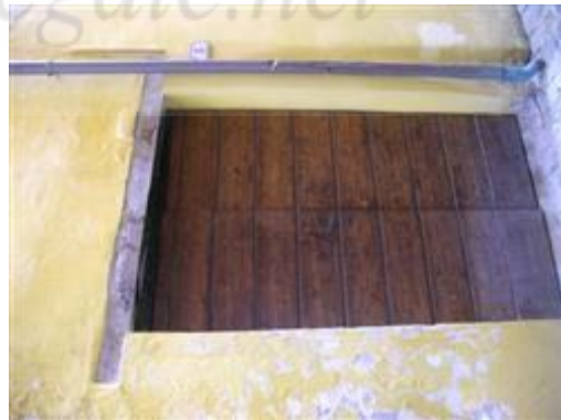
ingresso da Vicolo Particelli al seminterrato
