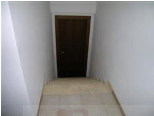
scale condominiali - accesso seminterrato
