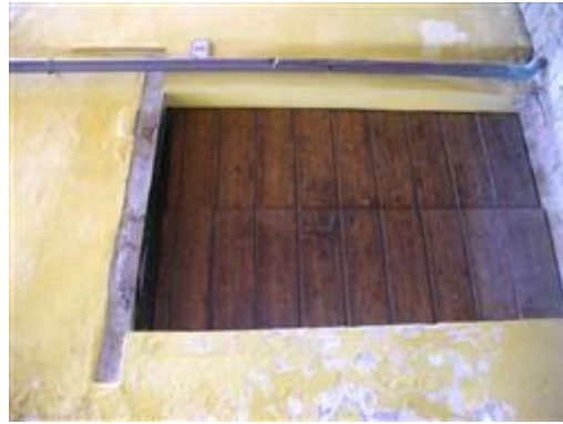
ingresso da Vicolo Particelli al seminterrato
