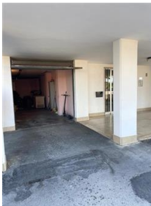
Garage PT accesso dal porticato condominiale (sub.47)
