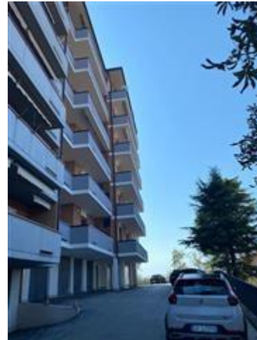
Esterno dell'immobile sito in Via Adone Zoli n.5 nel Comune di Montegranaro.
