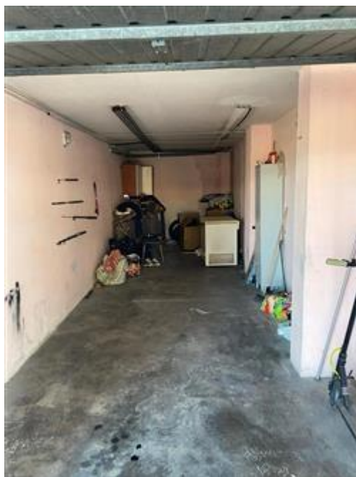
Interno del garage oggetto di esecuzione (sub.47), particolare della pavimentazione in cemento grezzo e dotato esclusivamente dell'impianto elettrico.
