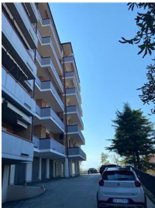
Esterno fabbricato Via Adone Zoli n.5 Comune di Montegranaro.
