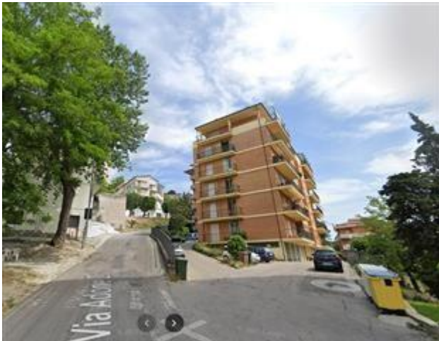
Strada di accesso all'immobile sito in Via Adone Zoli nel Comune di Montegranaro.
