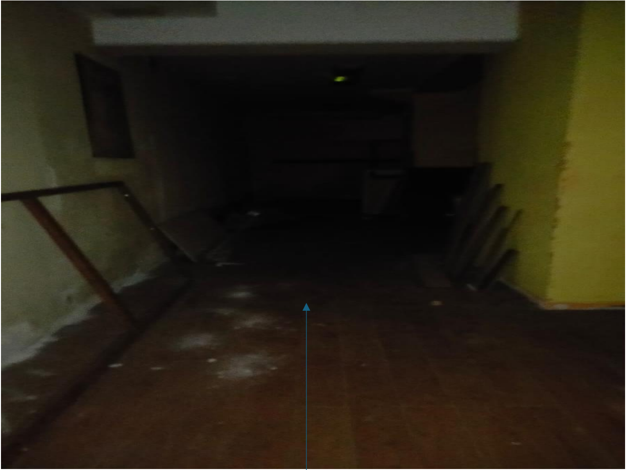
Vano di comunicazione di due unità immobiliari – che dovrà chiudersi
