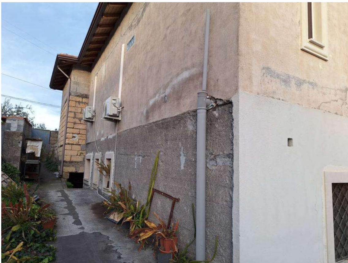
Foto 20 – Prospetto lato Ovest
