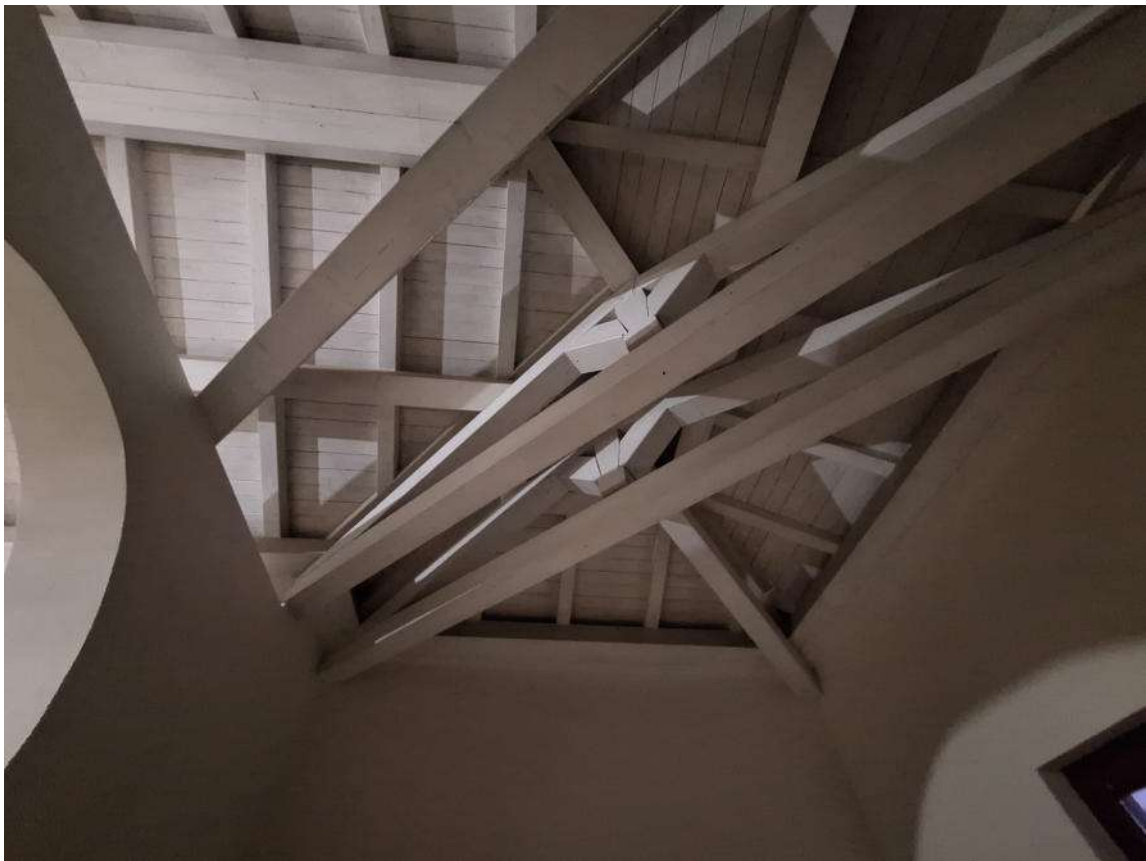
Foto 08 – Particolare copertura con capriata lignea
