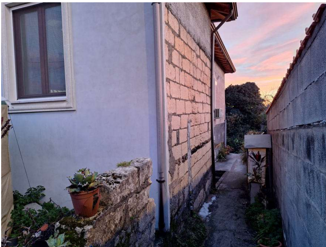
Foto 19 – Prospetto lato Ovest
