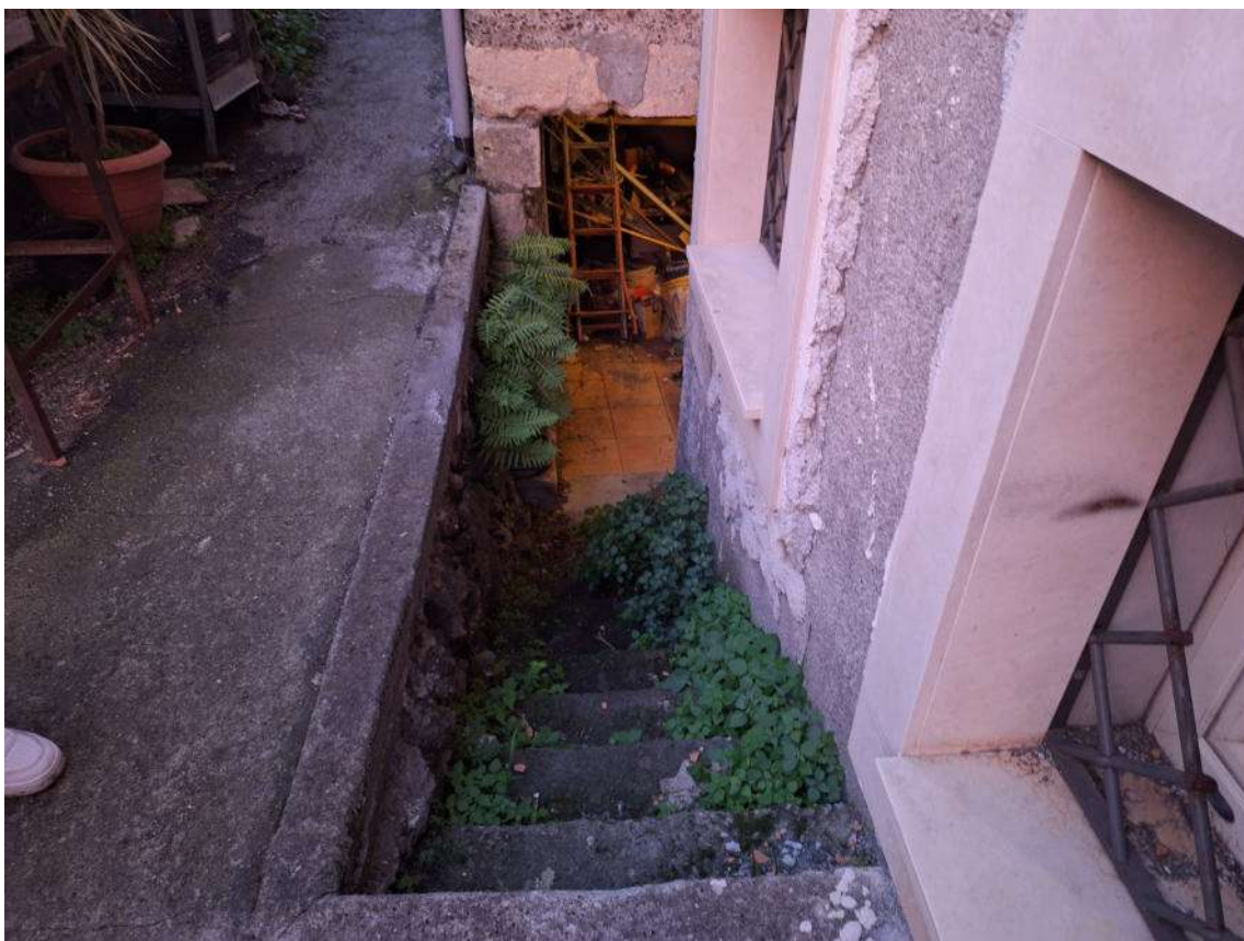
Foto 21 – Particolare scala d'accesso appendice vasca
