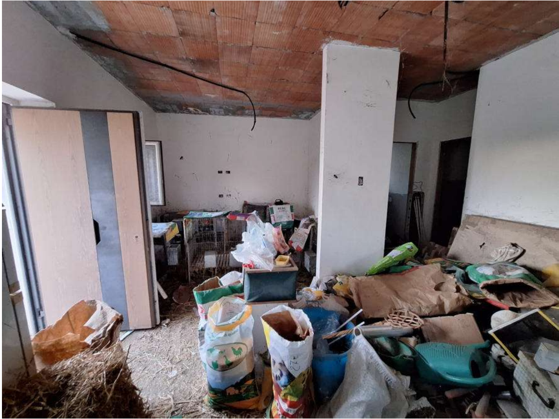
Foto 25 – Ingresso locale vasca
