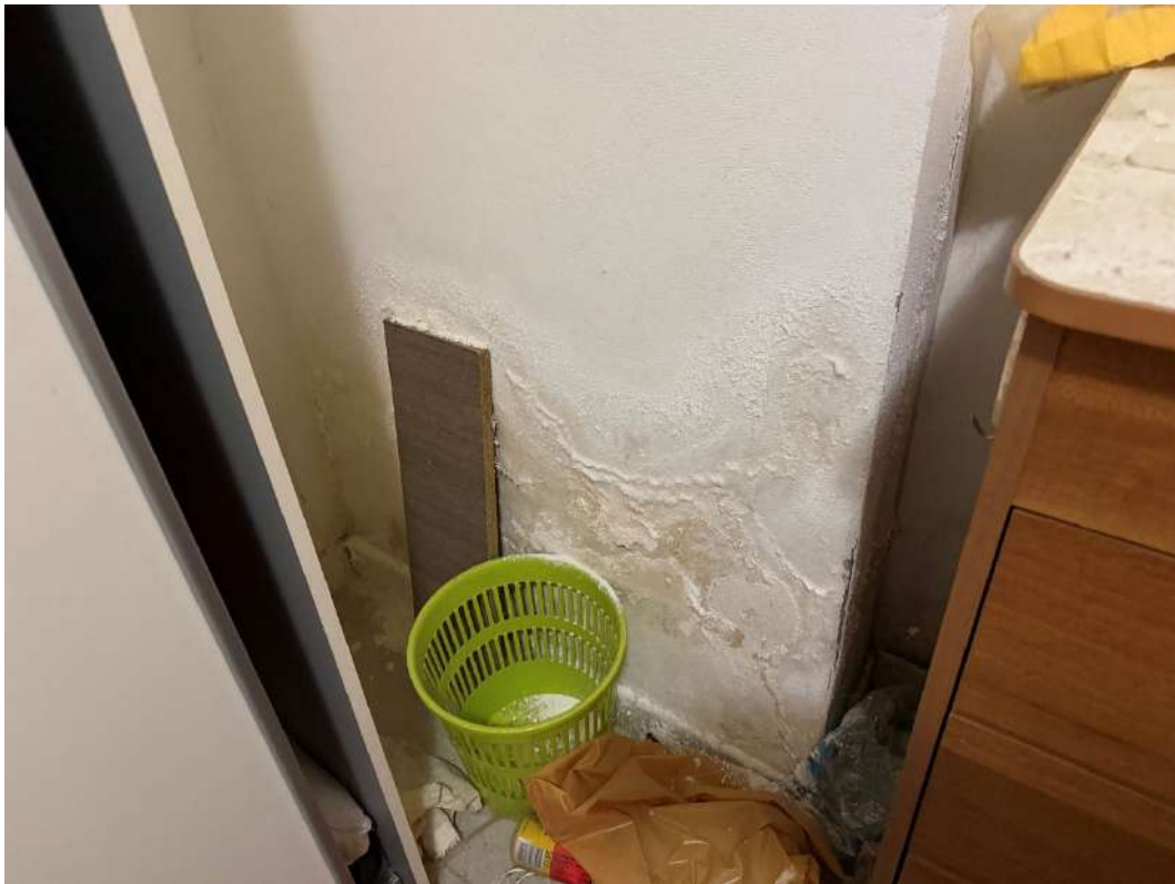
Danni da presenza di umidità/muffa alloggio p.m. 1
