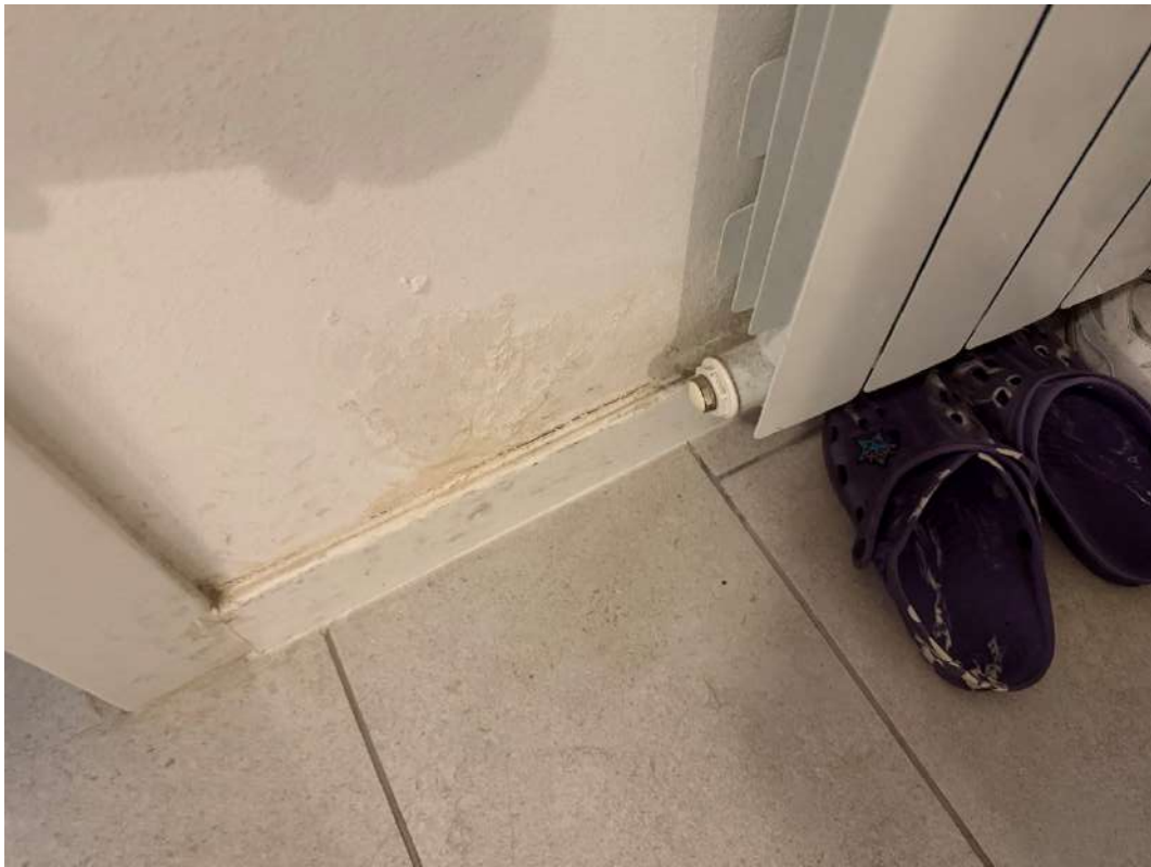
Danni da presenza di umidità/muffa alloggio p.m. 1
