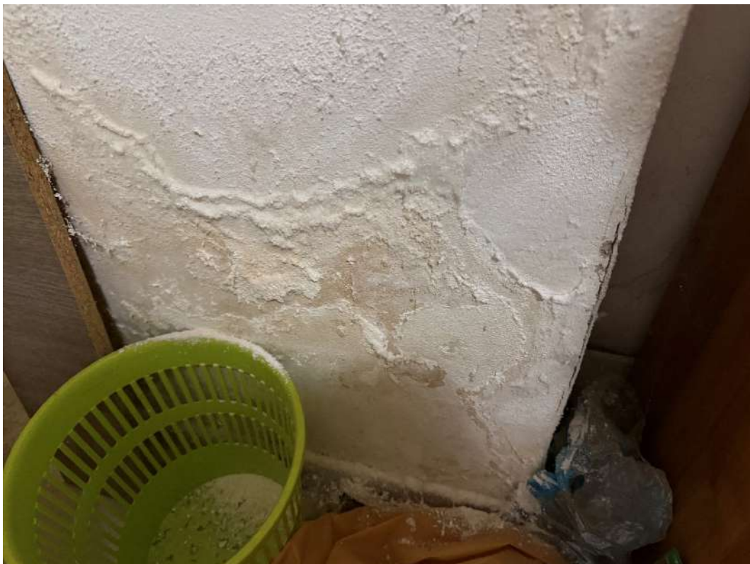
Danni da presenza di umidità/muffa alloggio p.m. 1
