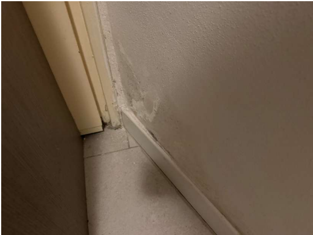
Danni da presenza di umidità/muffa alloggio p.m. 1
