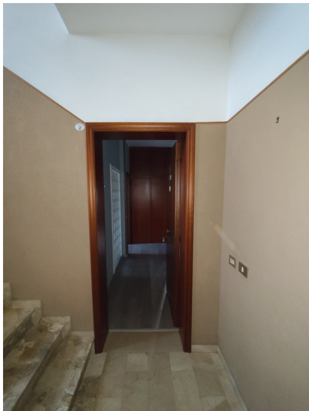
1.1 – accesso dal ballatoio comune
