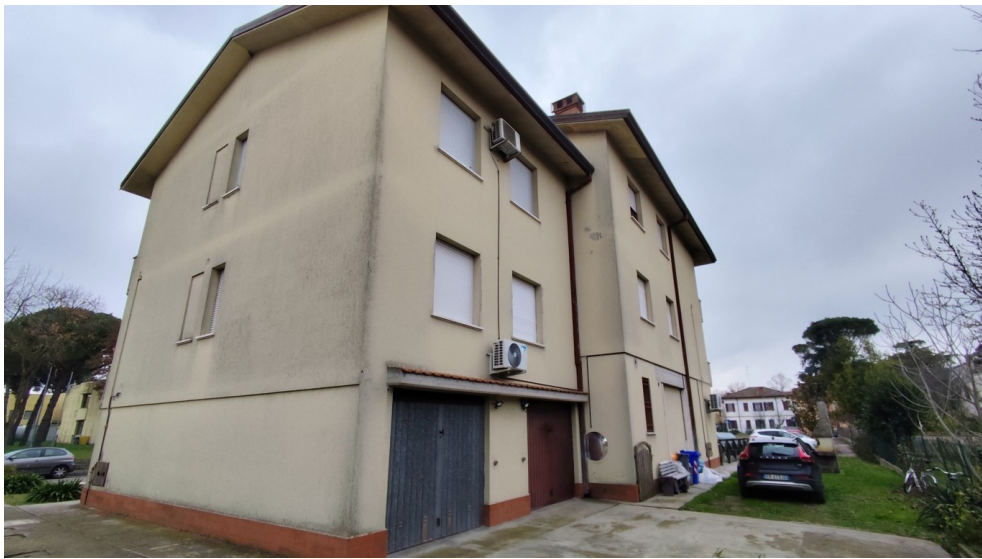
0.4 – vista da interno corte (lati nord e ovest)
