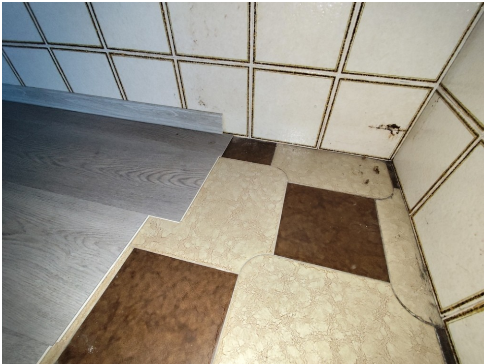
1.6 – cucina - particolare pavimento
