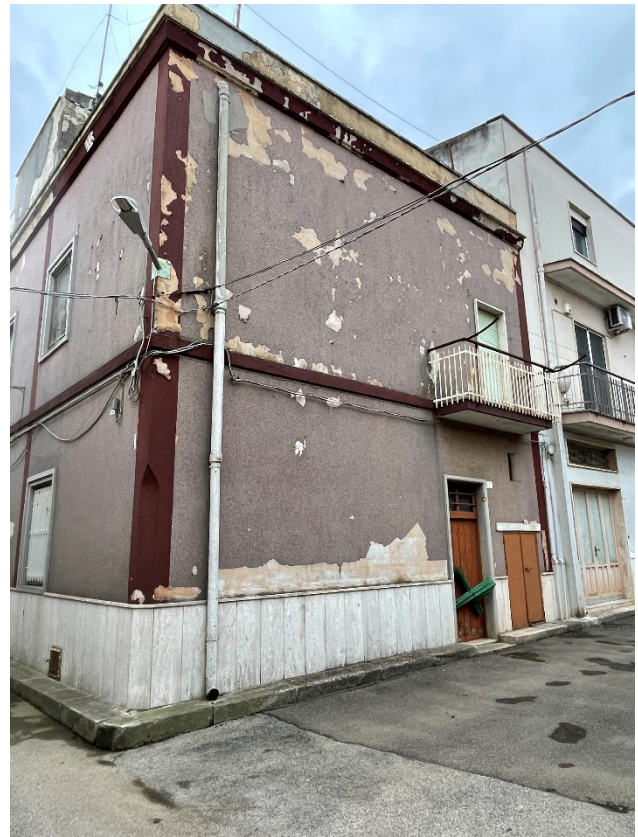
vista esterna angolare
