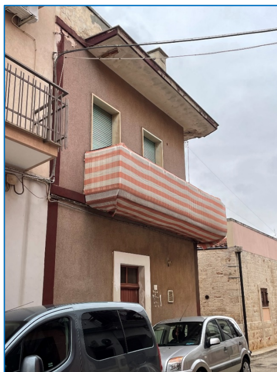
fig. 4 - vista fabbricato – accesso secondario all'immobile – via Di Vittorio 42
