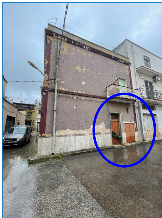
fig. 3 - vista fabbricato – accesso secondario all'immobile ed alla cantina – vico Gramsci
