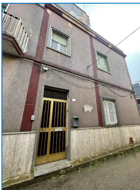
fig. 2 - vista fabbricato - accesso principale all'immobile- vico Gramsci 1
