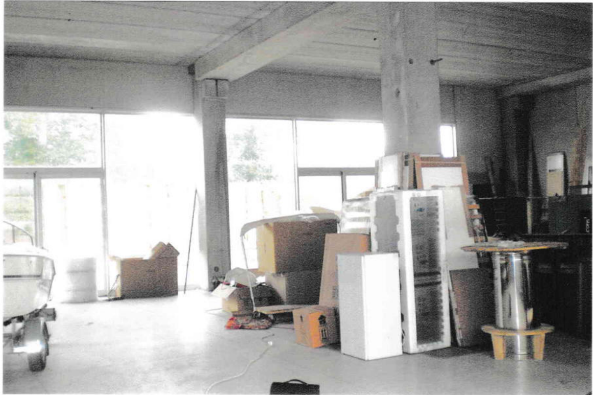
Foto 9 : PARTICOLARE MAGAZZINO AL PIANO TERRA
