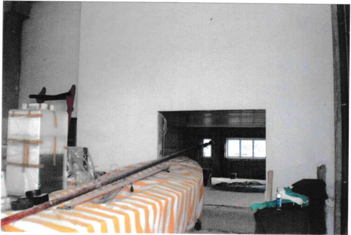
Foto 11: PARTICOLARE MAGAZZINO AL PIANO TERRA
