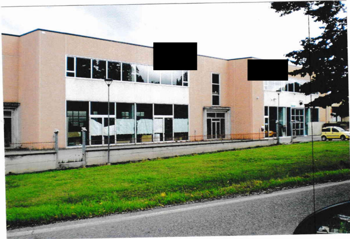
Foto 4 : particolare (B) facciata principale lato S.S.Traversa del Mugello
