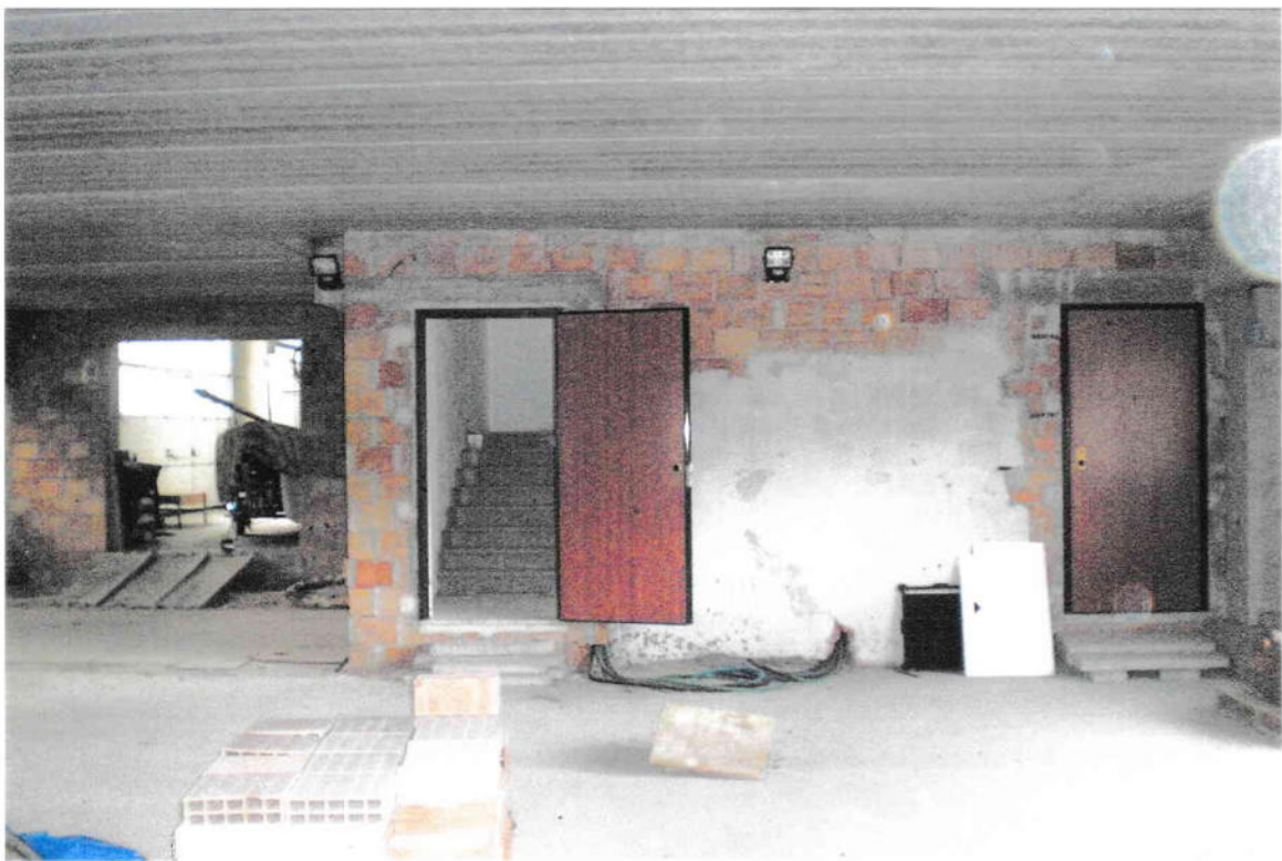
Foto 14: PARTICOLARE PORZIONE DI MAGAZZINO AL p.t. ( parte da completare come finiture )
