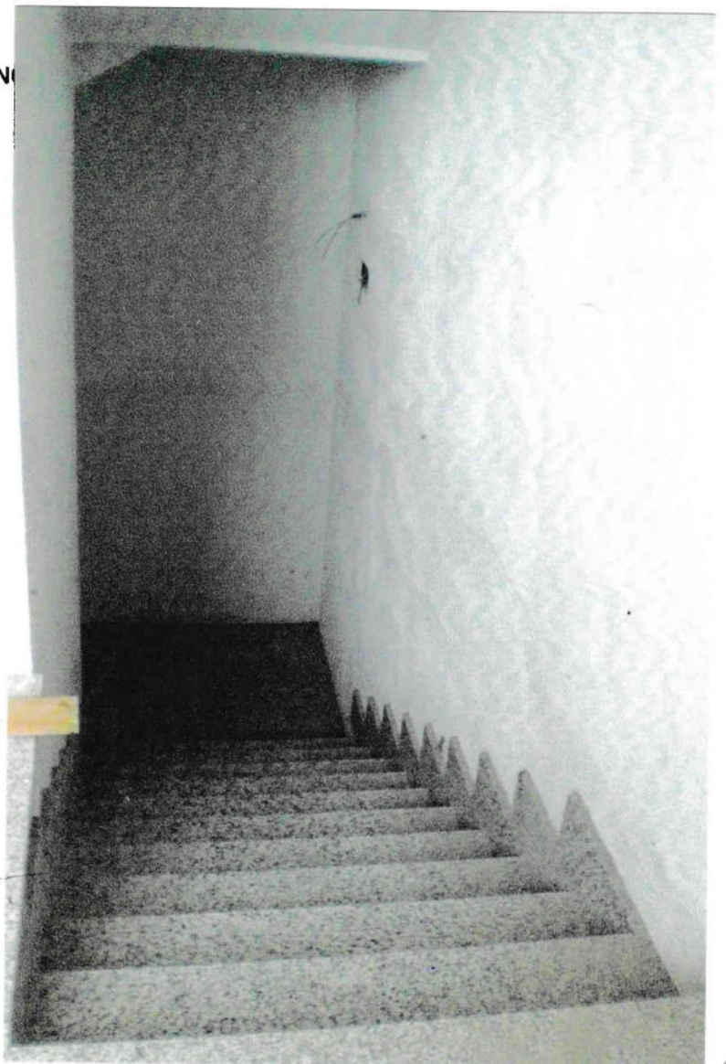
Foto 16: PARTICOLARE vano scala condominiale
