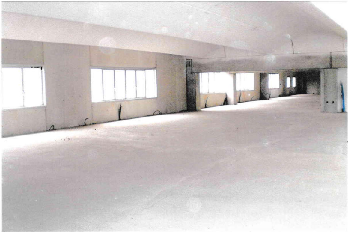
Foto 22: visione generale magazzino al piano 2°
