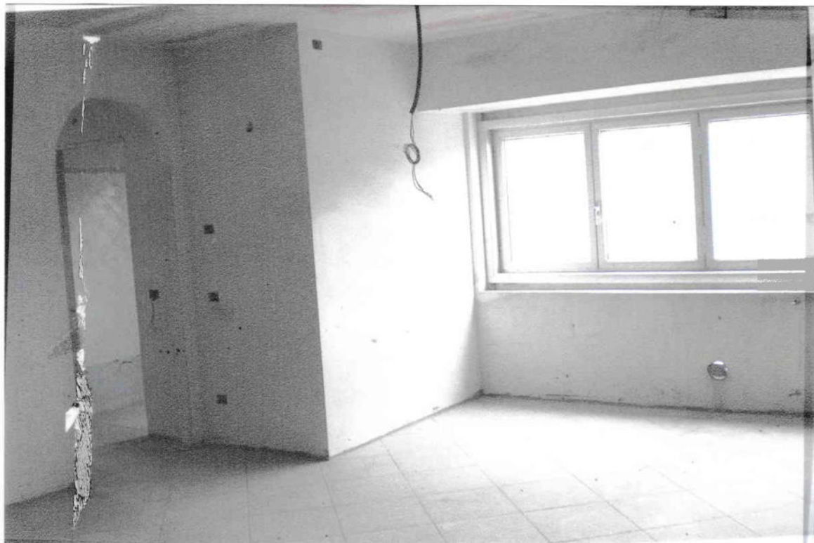
Foto 28: particolare ufficio al piano 2° (SOB.14)
