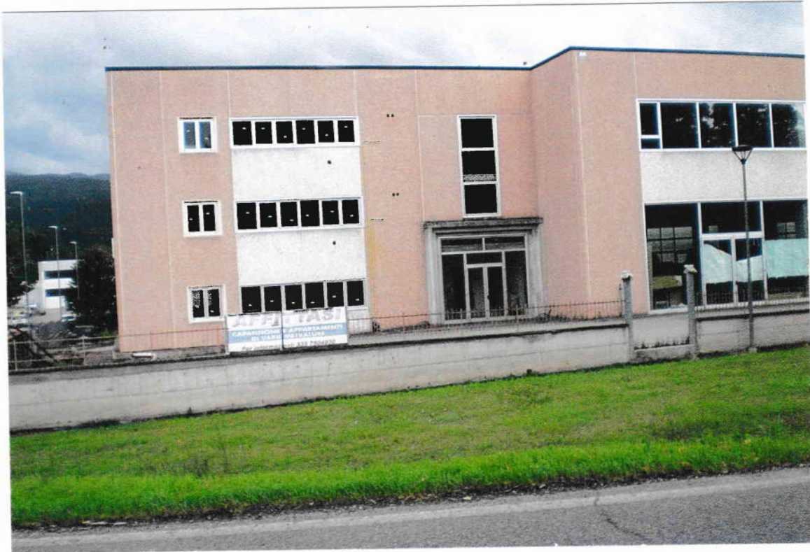
Foto 3 : particolare (A) facciata principale
