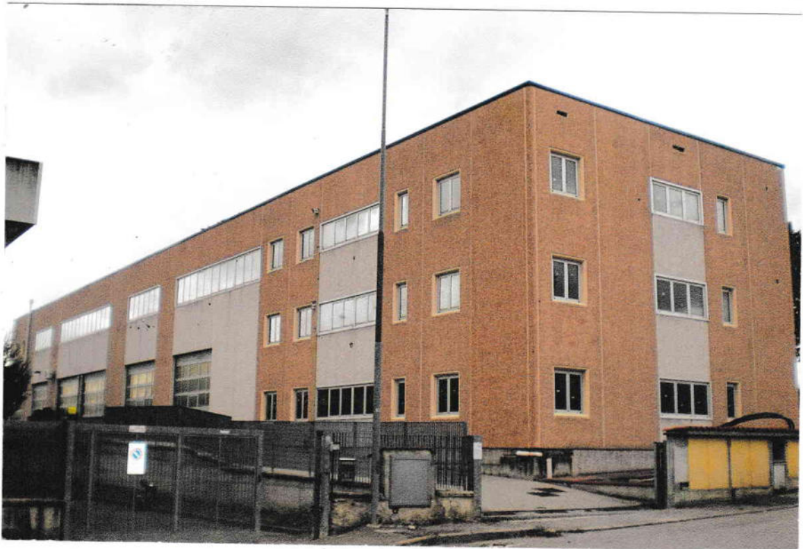
Foto 6: prospetto tergale capannone
