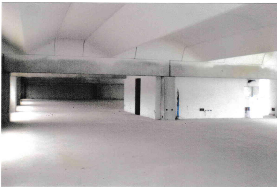
Foto 20: visione generale magazzino al piano 2°
