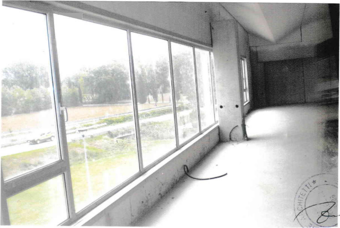
Foto 21: particolare affaccio verso la S.S.Traversa del Mugello del magazzino al piano 2°
