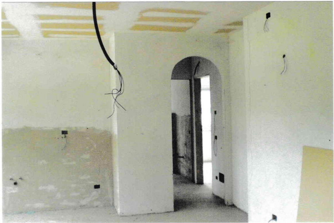
Foto 22: particolare appartamento al piano 2°
