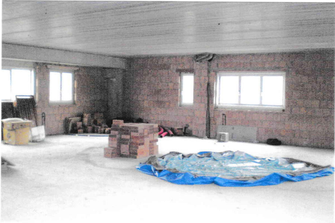
Foto 13: PARTICOLARE PORZIONE DI MAGAZZINO AL PIANO TERRA( PARTE DA COMPLETARE )
