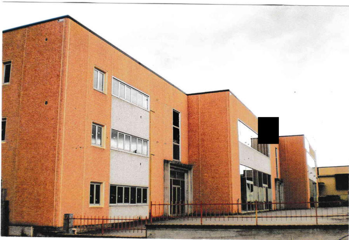
Foto 2 : prospetto principale lato S.S.Traversa del Mugello
