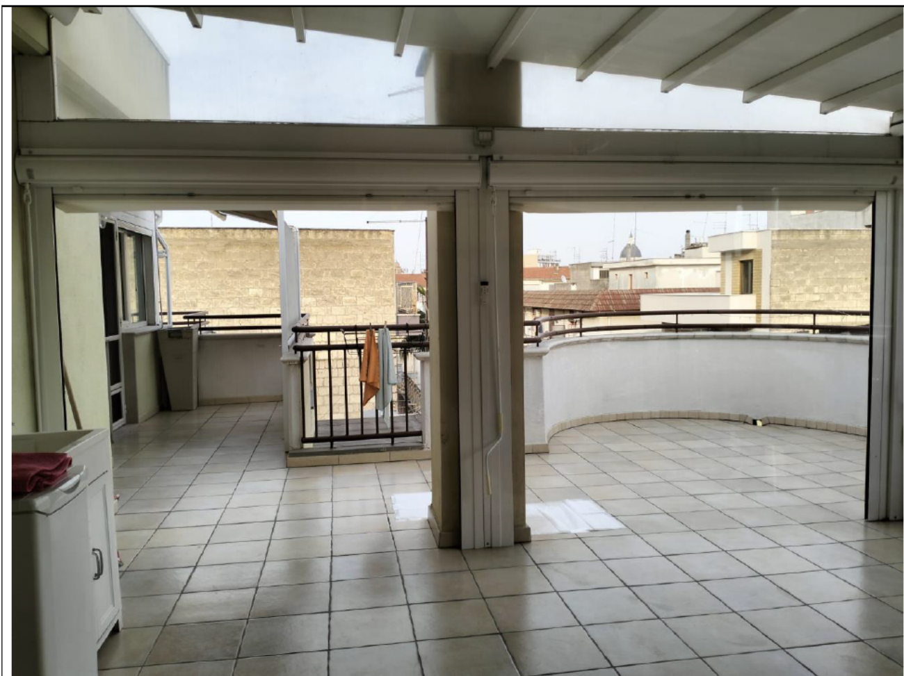
5 – Parte della tettoia non presente nella D.I.A., che andrà sanata
