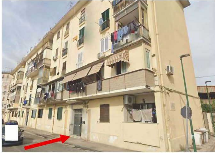
Foto n. 1: • Facciata principale su Via Ravello (evidenziato il portone della “Scala C” distinto dal civico 12).
