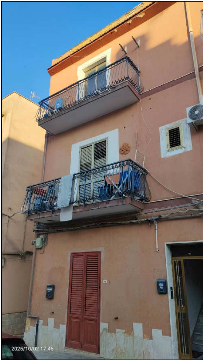
Foto n°1 : vista esterna dell'immobile
