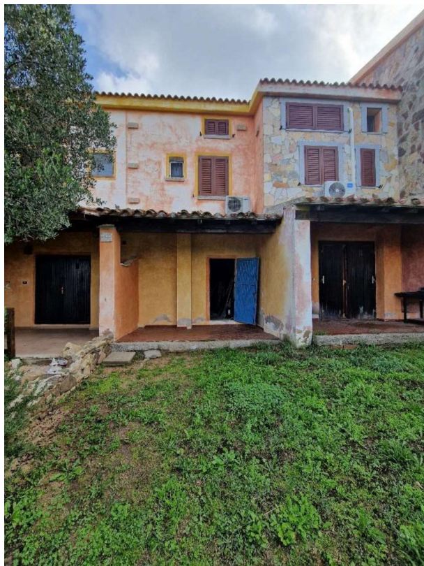
Fronte unità immobiliare
