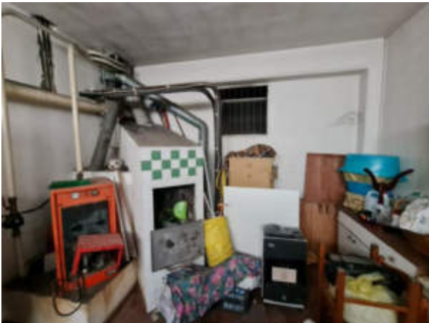
Locale tecnico al piano seminterrato
